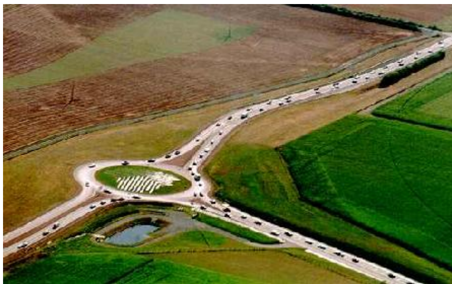
Slika 11 : Večpasovno krožno križišče na Nizozemskem. Vir: Center for Transportation Research and Training.
