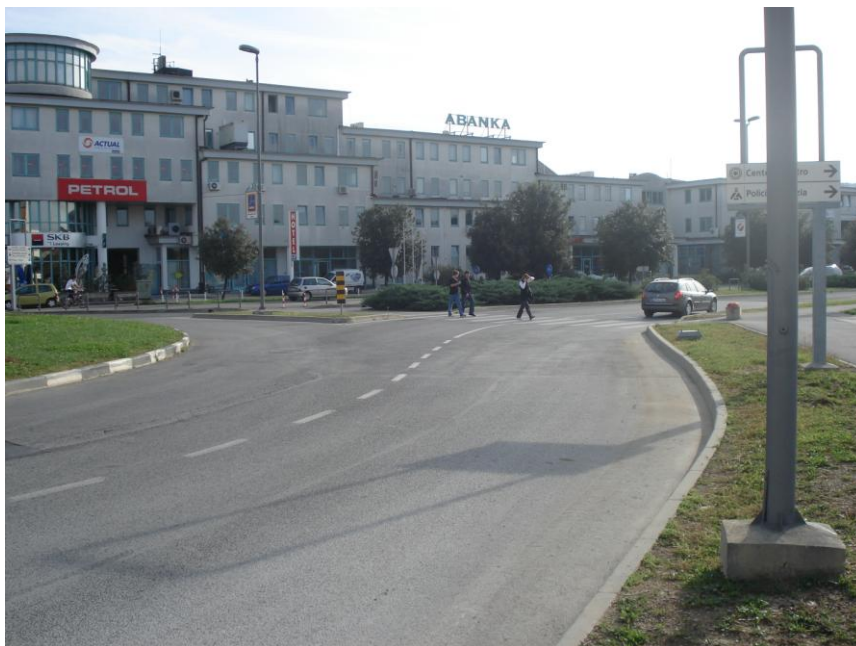
Slika 24 : Oblika črte v večpasovnem krožnem križišču v Kopru. Vir : Lasten vir
