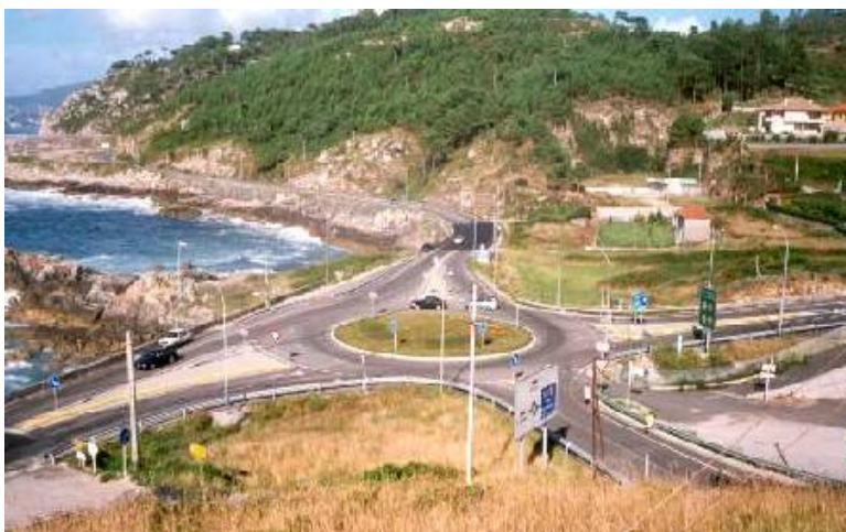
Slika 12 : Večpasovno krožno križišče v Španiji. Vir: Center for Transportation Research and Training.
