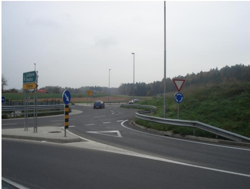
Slika 20 : Prikaz konfliktnega odseka na večpasovnem krožnem križišču v Novem mestu. Vir: Lasten vir
