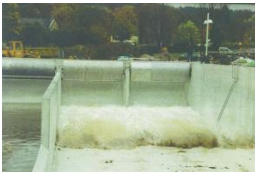
Slika: Bazen ob prevrnitvi prekucnega korita (AWS Spülkippe,ni datuma)
