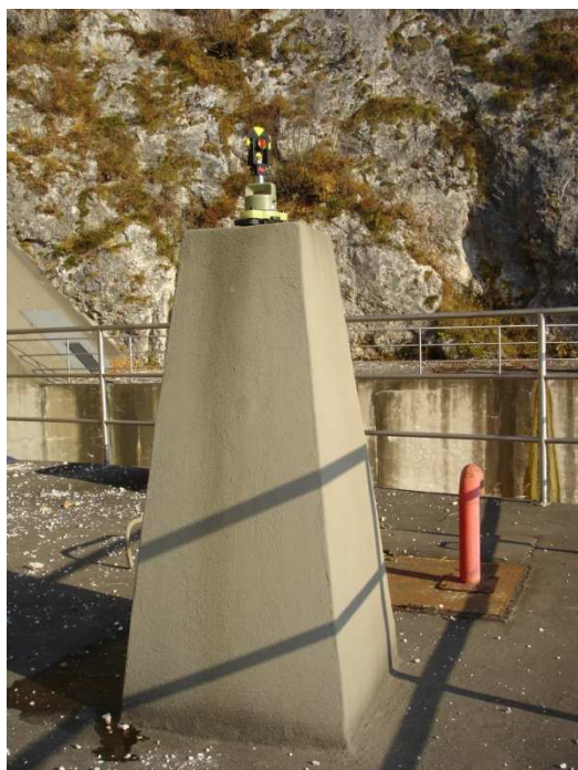
Slika 14: Stabilizacija in signalizacija točke XI, Moste 2006
