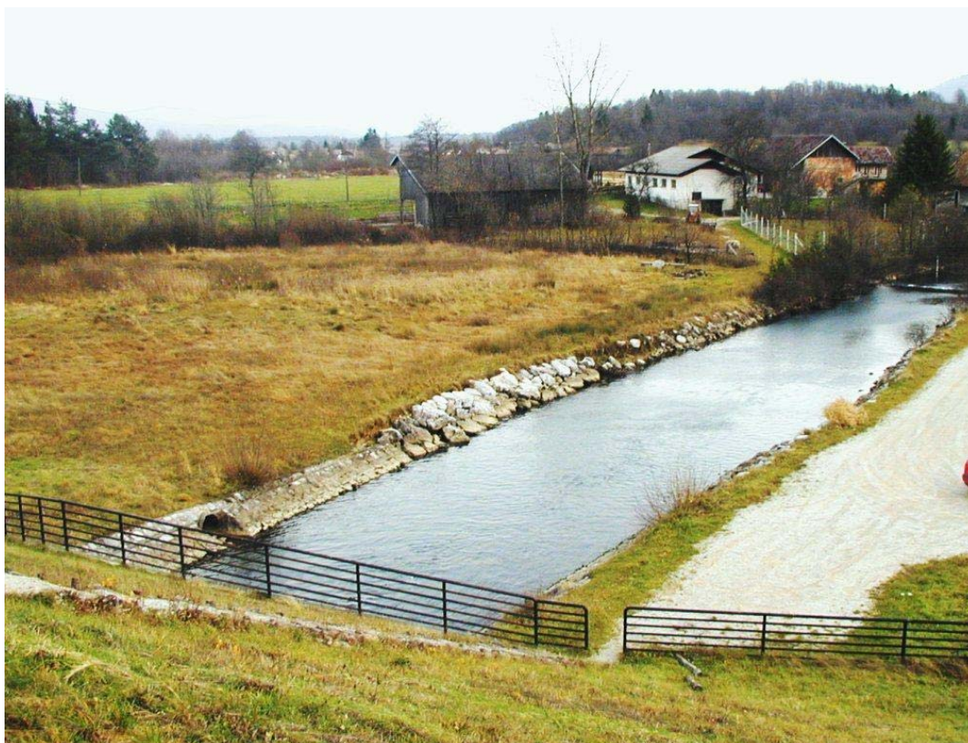
Slika 9: Ureditev brežine za izpustom (Fazarinc, 2002)
