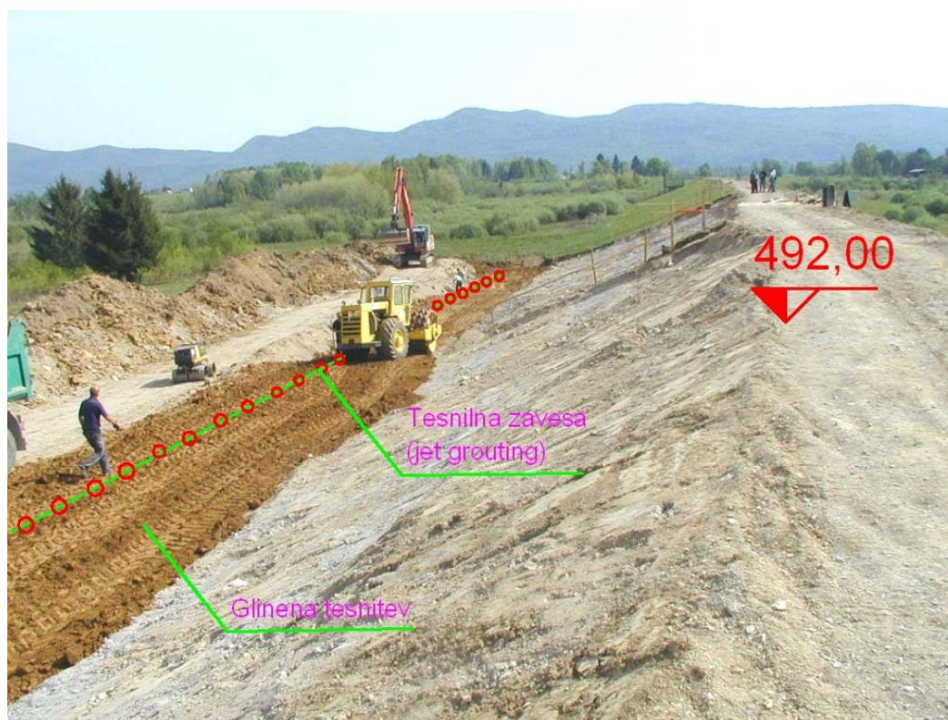
Slika 8: Izvedba sanacije pregrade (Fazarinc, 2001)
