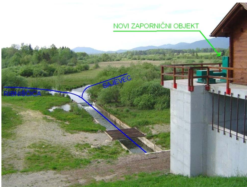
Slika 17: Sotočje Ribniščice in Sajeveca pred zaporničnim objektom
