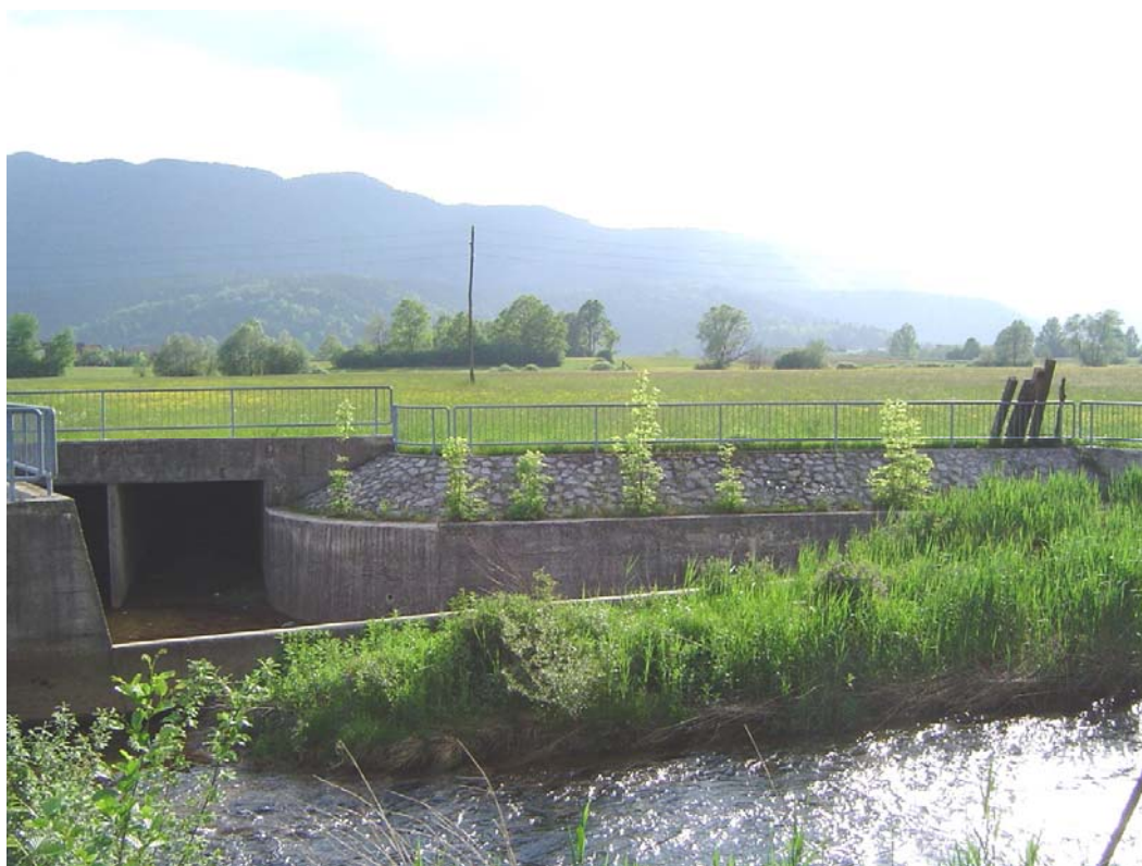
Slika 4: Razdelilni objekt visokih voda v Gornji vasi
