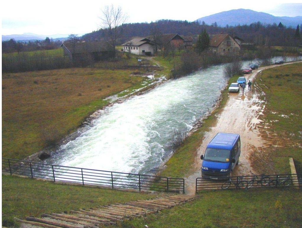
Slika 6: Izpust iz akumulacije 23.11.2000 (Fazarinc, 2000)
