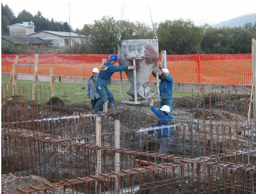
Slika 5.7 : Betoniranje temeljne pete
