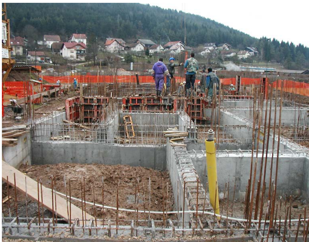
Slika 5.10 : Opaž nadvišanih temeljnih nastavkov
