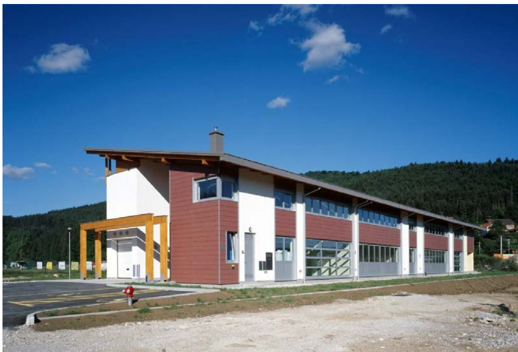
Slika 5.2: Varstveno delovni center- VDC Cerknica, JV fasada
