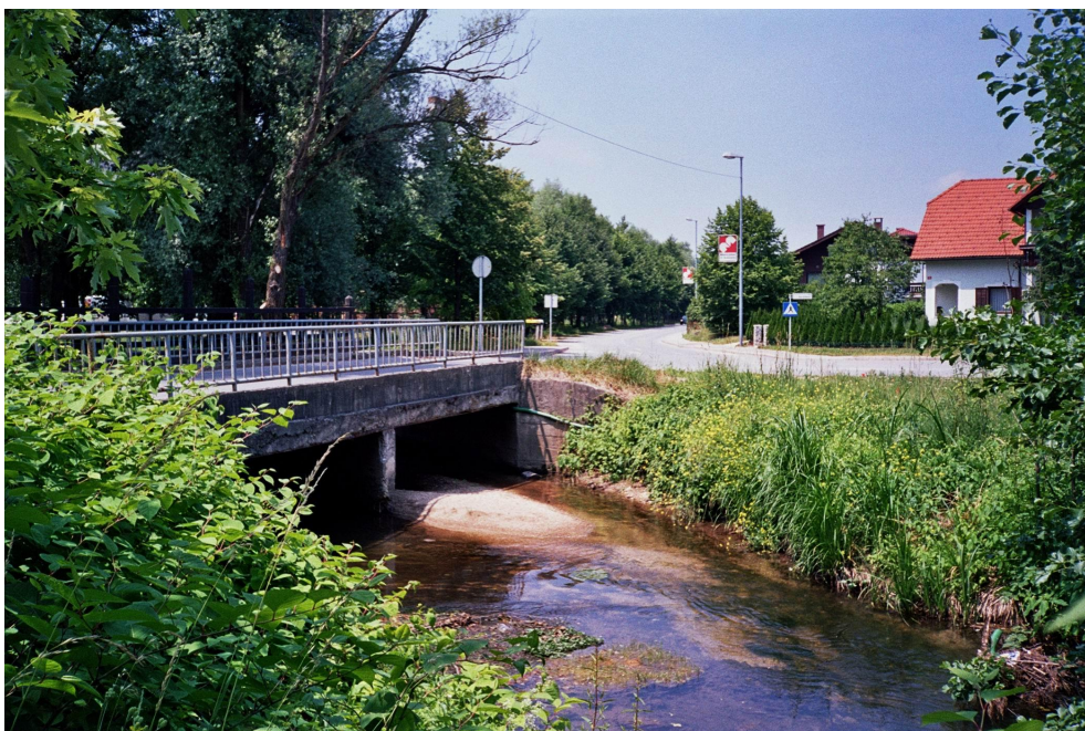
Slika 14: Most predviden za odstranitev
