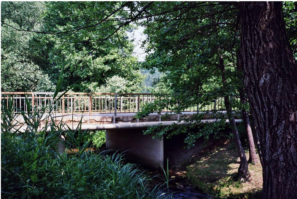
Slika 6: Betonski most pri trgovsko obrtni coni
