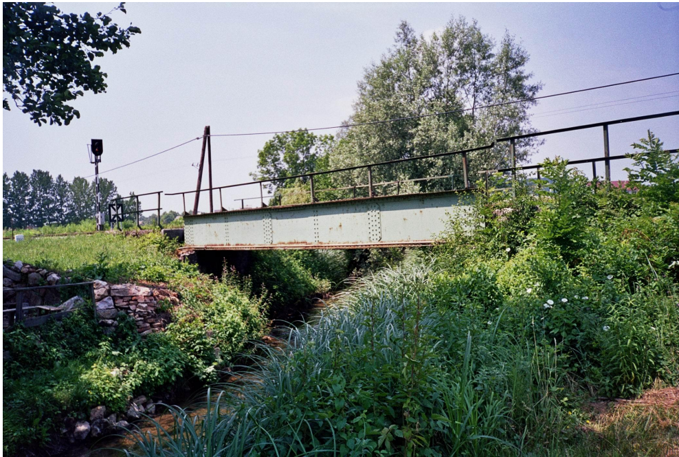
Slika 18: Železniški most na progi Ljubljana - Novo mesto, pogled gorvodno
