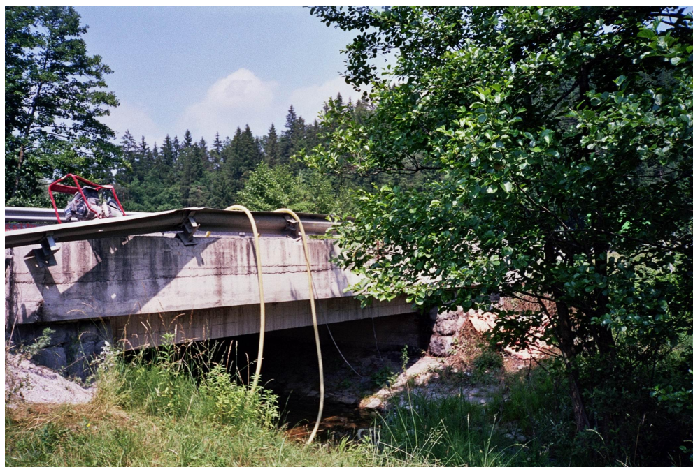
Slika 2: Most na avtocesti proti Novemu mestu
