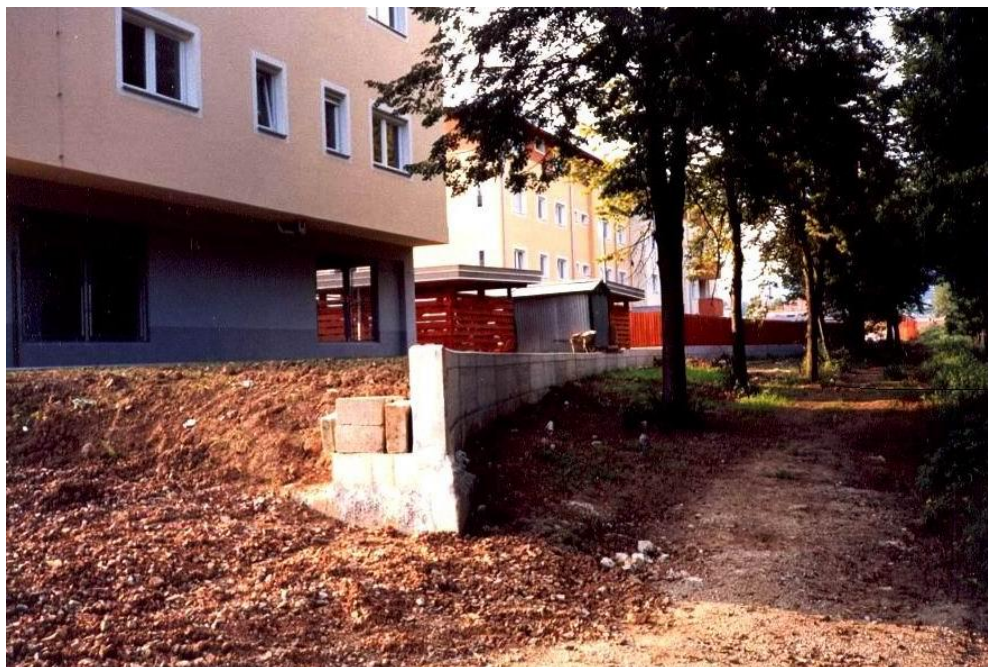
Slika 7: Novogradnja objektov pri osnovni šoli
