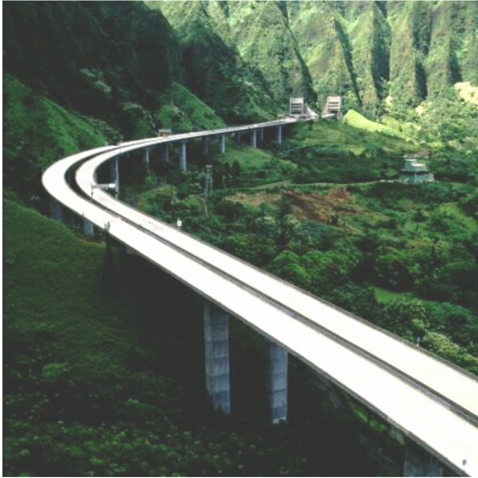
Slika: Primer lepega prelivanja viadukta z okolico v okolici Honoluluja, ZDA (vir: Spletna stran: http://www.fhwa.dot.gov/eihd/ .)
