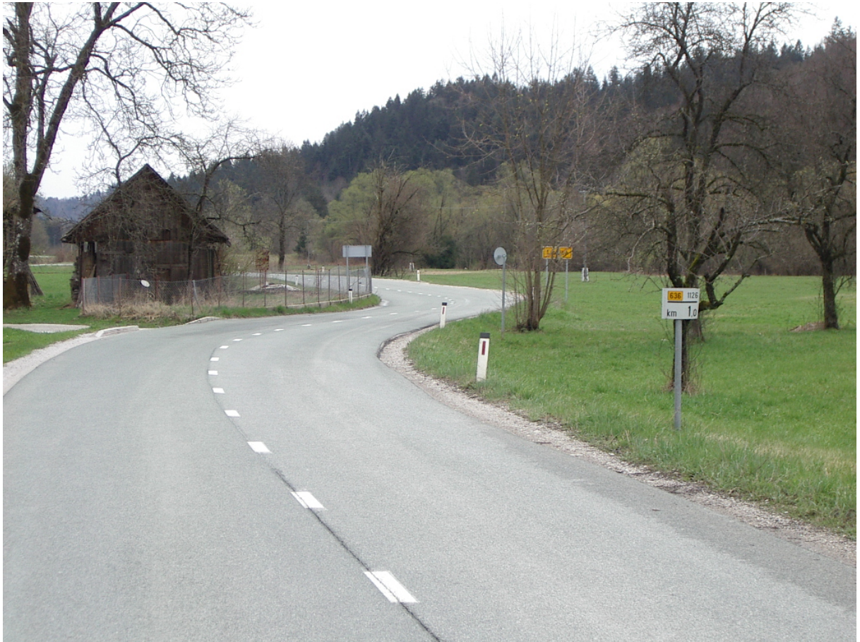
Slika: Prikazuje primer vožnje čez rob. Regionalna cesta odsek Lipnica Kropa.( vir foto: Tadej Berčič)
