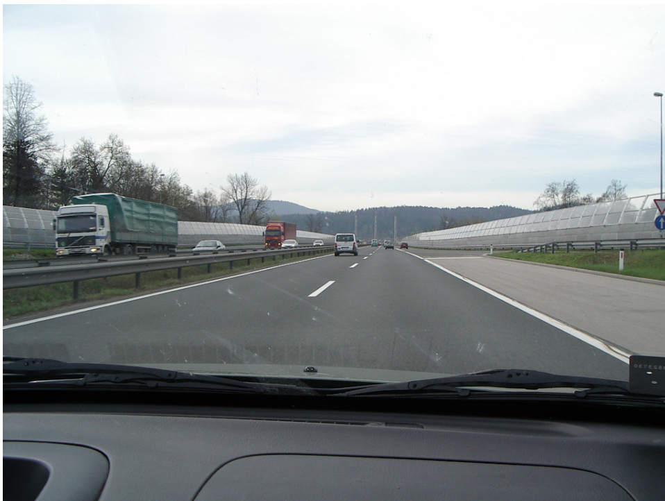
Slika:Primer kako lahko protihrupne ograje prikrajšajo pogled na okolico. Obvoznica Ljubljana Vzhod(vir:foto Tadej Berčič)
