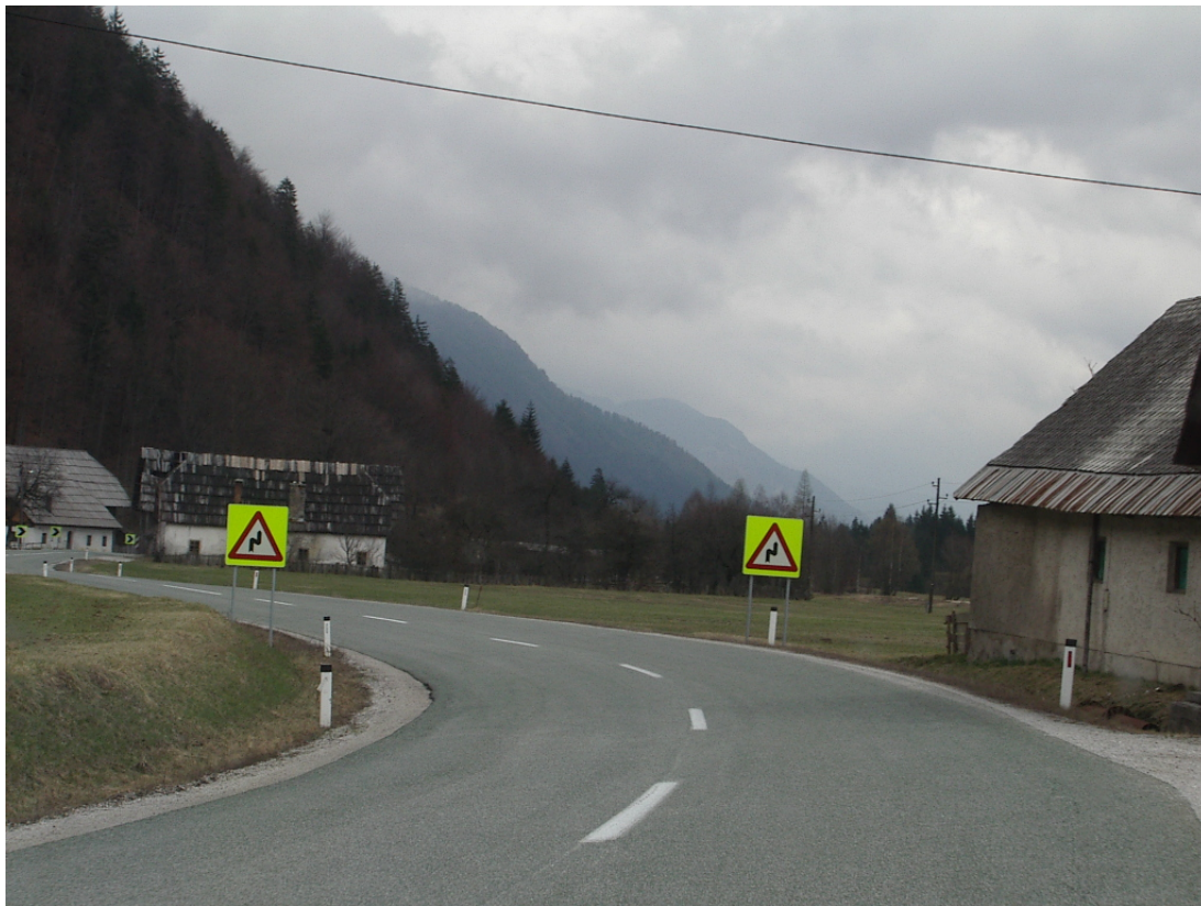
Slika: Signalizacija na nevarnem mestu, kje stoji tabla in je cesta napačno speljana. Cesta Kranjska gora Jesenice. (vir:foto Tadej Berčič)
