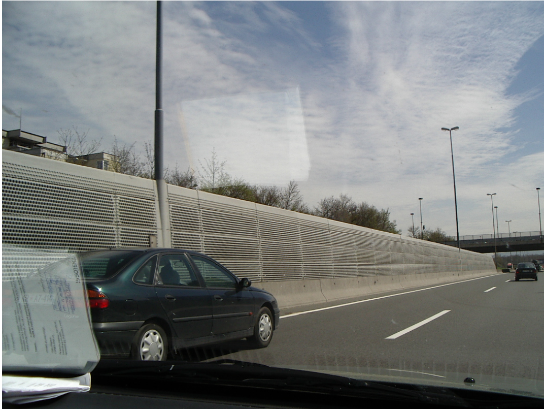
Slika: Proti hrupna ograja na sredini ceste na severni ljubljanski obvoznici. (vir:foto Tadej Berčič)
