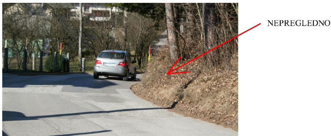
Slika 31: Nepregledna krivina na začetku Zg. Bele iz smeri Preddvora (slikano iz nasprotne smeri stacionaže)
