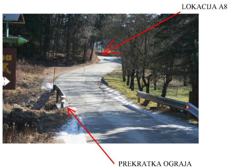
Slika 30: Prepust na Zg. Beli
