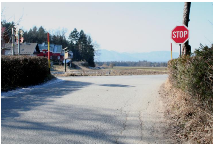
Slika 46: Nepregleden priključek na Sr. Beli.
