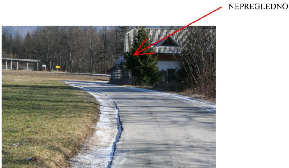
Slika 44: Nepregledna krivina na cesti C med Zg. in Sr. Belo (slikano v obratni smeri stacionaže)
