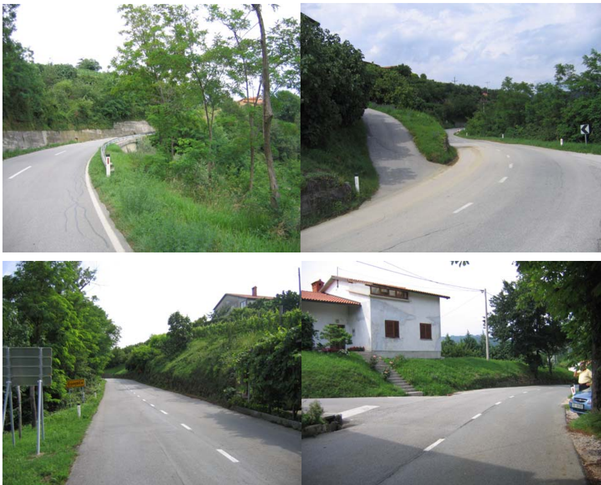
Slika 3.1: Območje rekonstrukcije ceste
