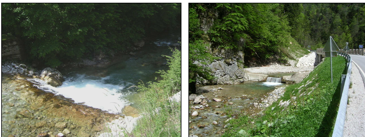
Avtorski sliki 3: Pragovi za umirjanje vodnega toka na gorski reki Kokri
