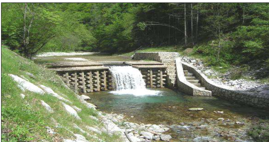
Avtorske slike 7: Hidrotehnično urejanje hudournih voda – prikaz na primeru Kokre; zadnja fotografija: nova ribja steza (vodna lestev)
