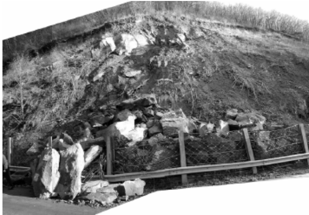
Slika 3.16 Skalni udor ( povzeto po Flum, D., Rügger, R. Zbornik 13. DEC )
