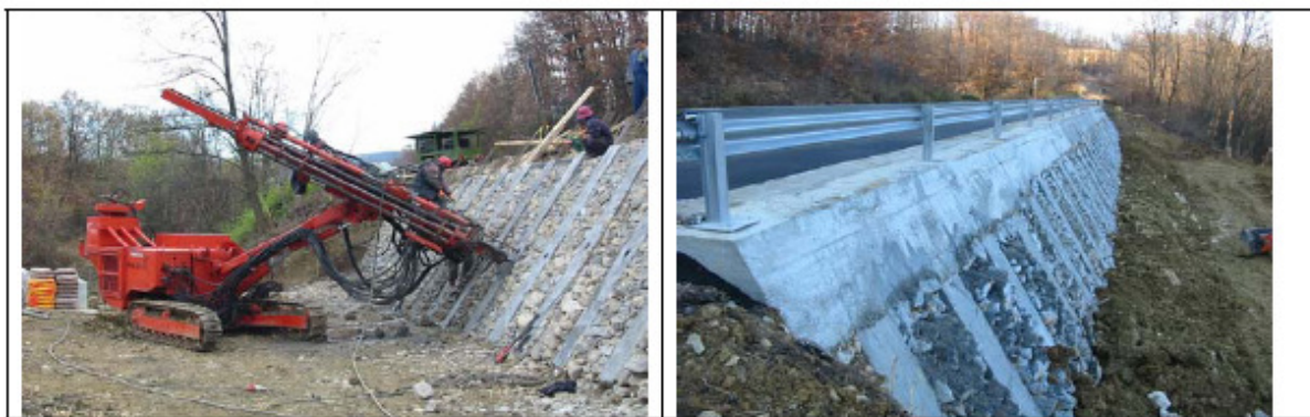
Slika 3.12 Stabilizacijska struktura med gradnjo in po njej ( povzeto po Frangov, G., Hamova, M. Zbornik 13. DEC, km 7+500, na cesti III-406 Sevlievo-Dryan, )
