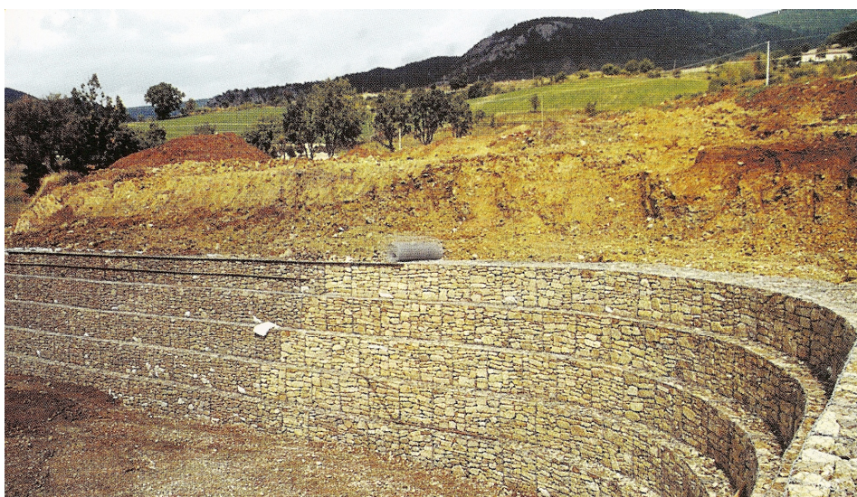
Slika 3.9 Podporna konstrukcija iz gabionov
