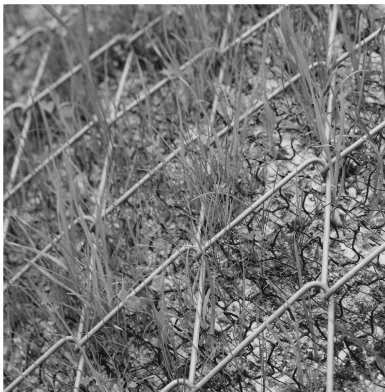
Slika 3.14 Močno raztegljiva žičnata zaščitna mreža za stabilizacijo pobočja ( povzeto po Flum, D., Rüegger, R. Zbornik 13. DEC )
