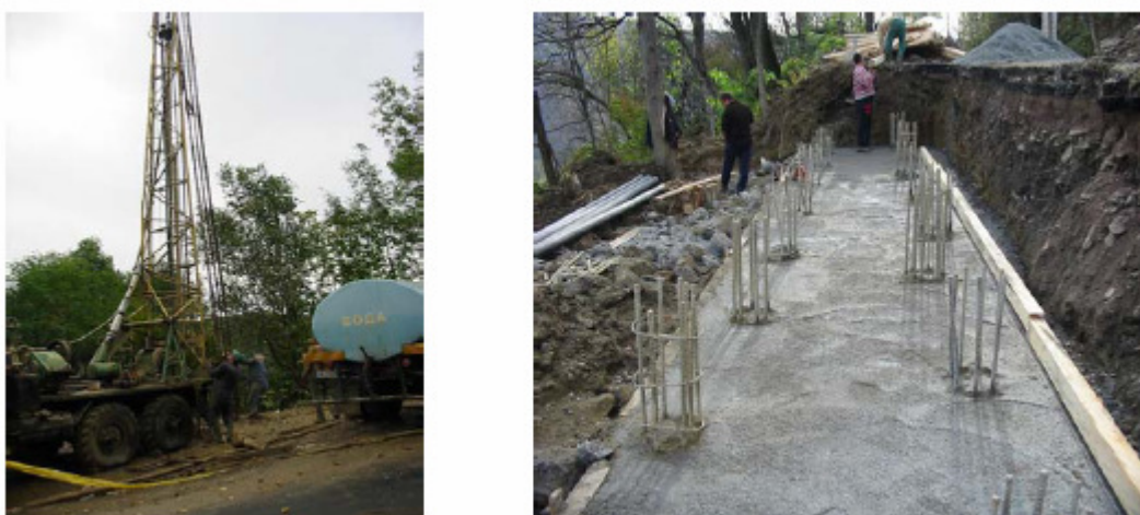
Slika 3.4 Namestitvev armature in zgornji deli opornikov ( povzeto po Hamova, M., Frangov, G., Zayakova, H. Zbornik 13. DEC )
