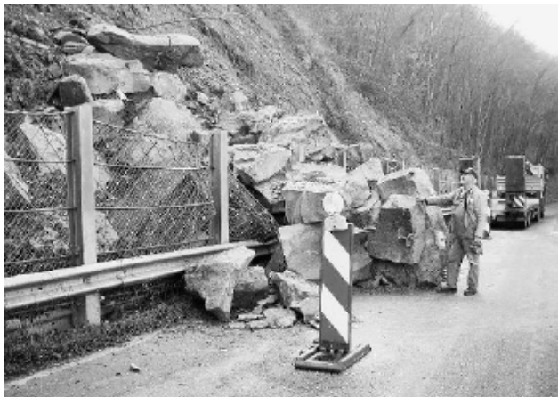
Slika 3.17 Skalni udor, ki je povzročil začasno zaporo regionalne ceste ( povzeto po Flum, D., Rügger, R. Zbornik 13. DEC )
