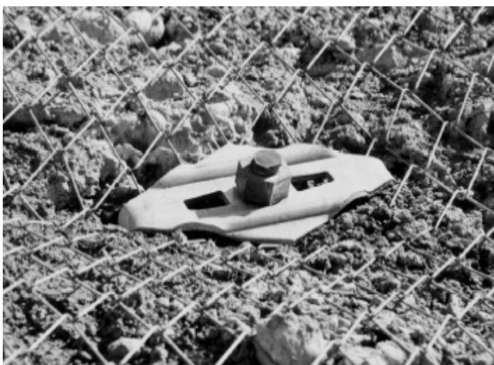
Slika 3.15 Posebna plošča z žabljem, ki aktivno pritiska na zelo raztezno jekleno zaščitno mrežo proti strmemu površju (povzeto po Flum, D., Rüegger, R. Zbornik 13. DEC)
