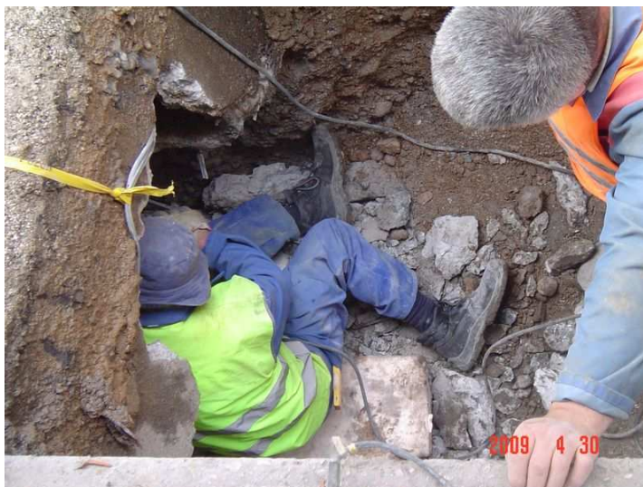
Slika 31: Izvajanje rušitvenih del na obstoječi kineti za potrebe novega toplovoda
