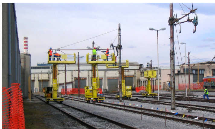
Slika 29: Odstranjevanje vozne mreže s strani ŽGP - ja
