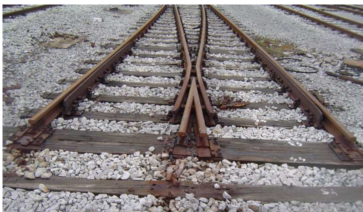
Slika 30: Odstranitev tirov in pragov
