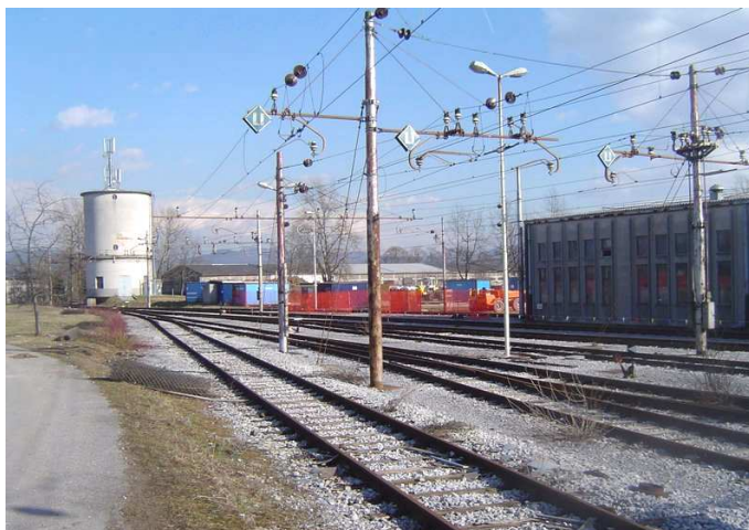
Slika 28: Odstranitev vozne mreže in tirov je bil pogoj za začetek izvajanja zemeljskih del
