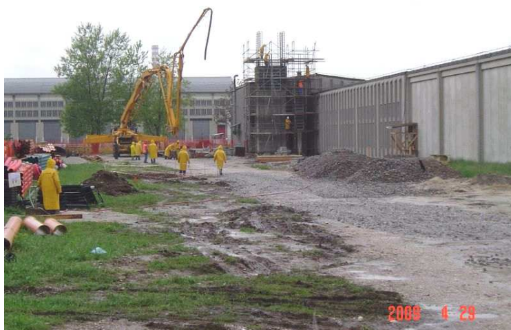
Slika 25: Betoniranje dvigalnega jaška v deževnih razmerah
