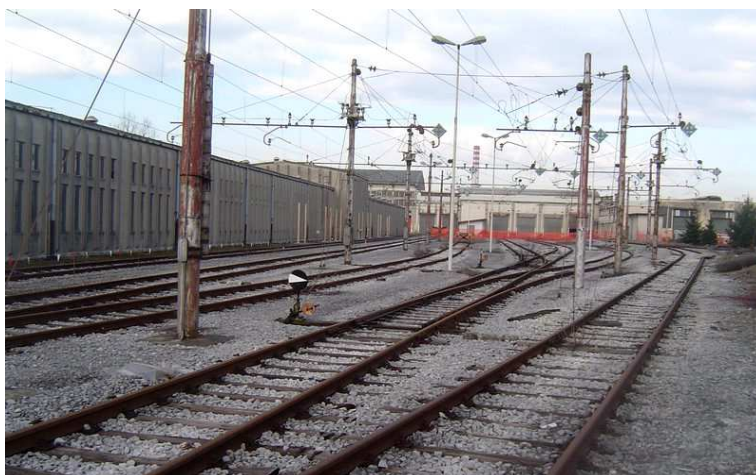
Slika 22: Obstoječe stanje pred pričetkom gradnje
