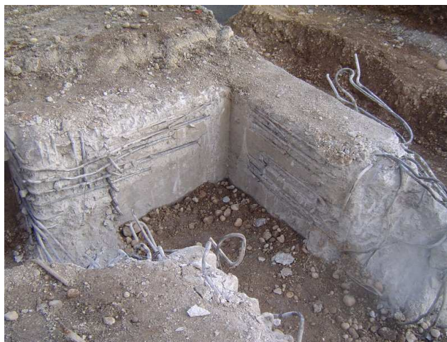
Slika 32: Tudi del obstoječega temelja (močno armiranega) je bilo potrebno porušiti
