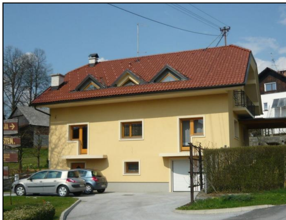
Slika 39: Modernejše obnovljena starejša stavba.
