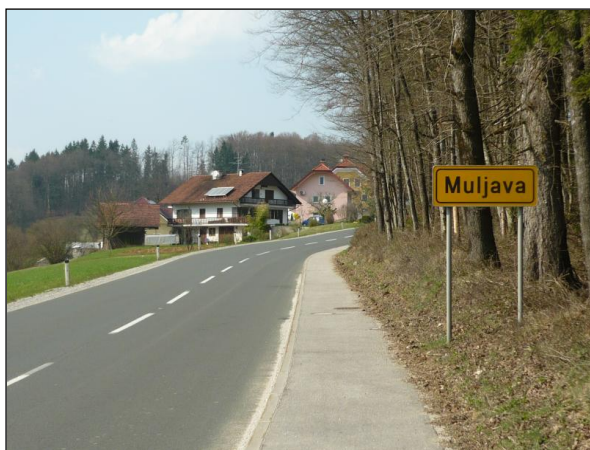
Slika 25: Obnovljena cesta s pločnikom ob vstopu v naselje
