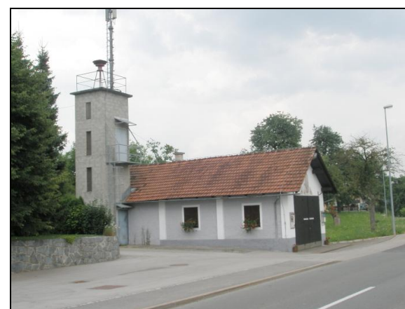
Slika 47: Gasilski dom brez funkcionalnega zemljišča
