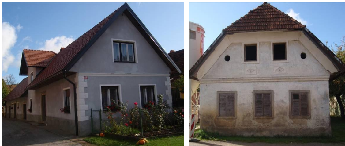
Slika 25: Nenaseljena stanovanjska stavba (dobro vzdrževana)
