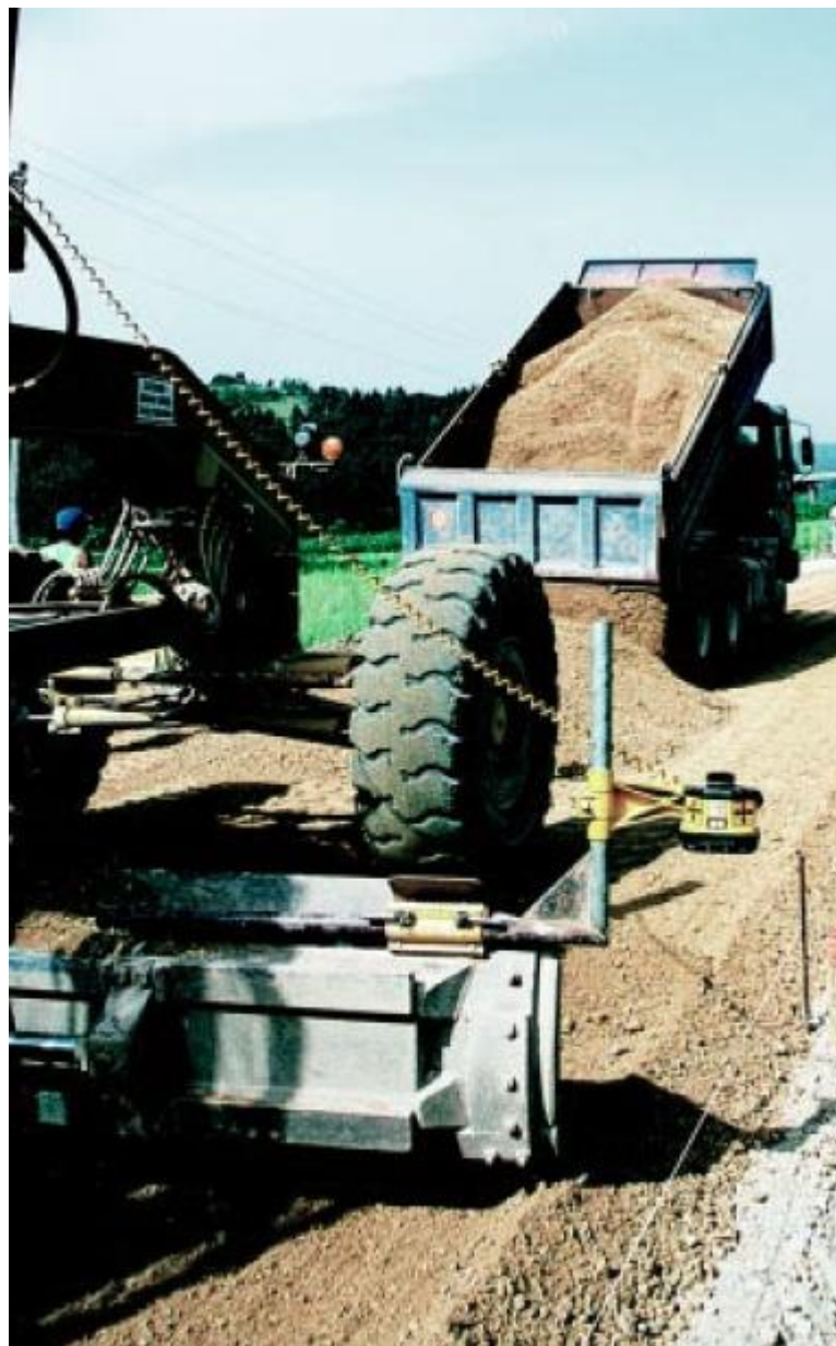
Slika 22: Planiranje z grederjem [37]
