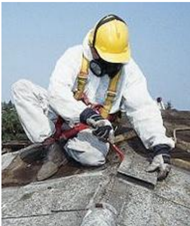
Slika 15: Odstranjevanje strešne kritine z vsebnostjo azbesta [35]
