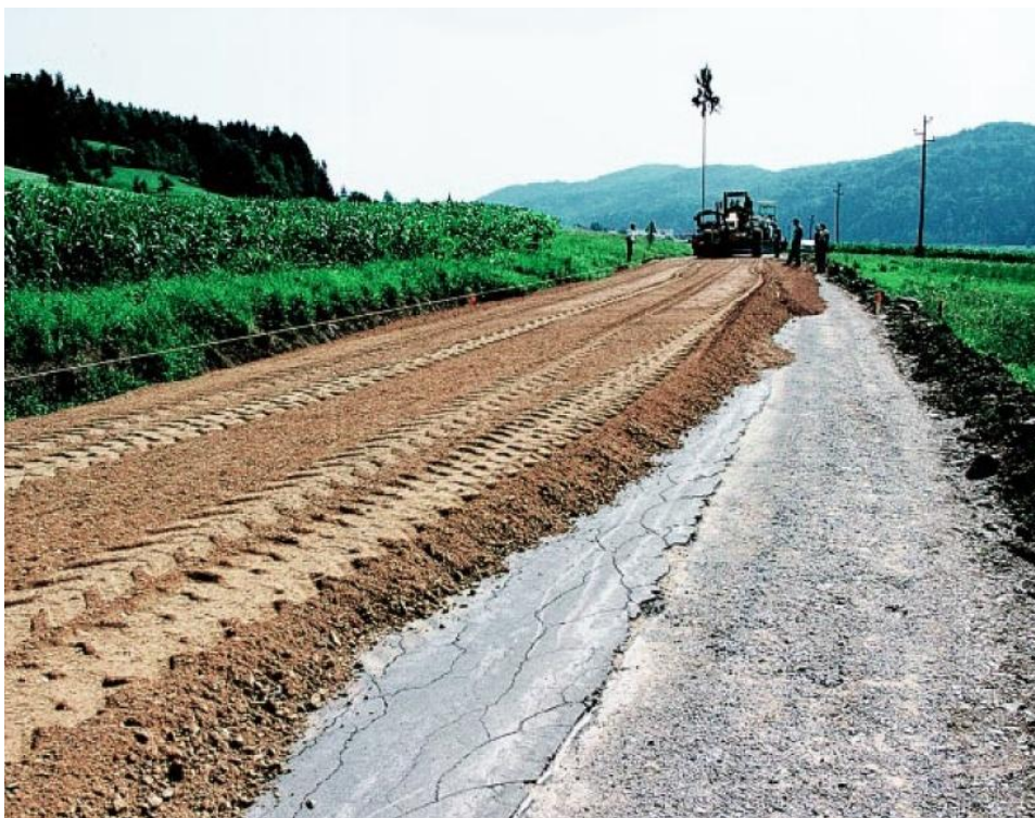
Slika 21: Nasutje drobljenega materiala [37]
