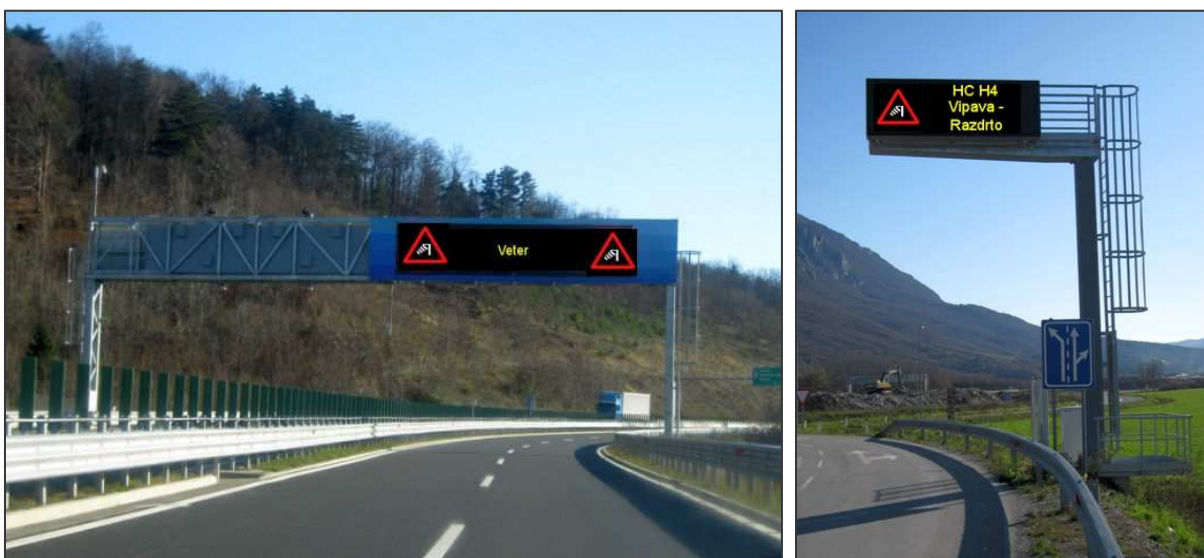
Slika 28: SPIS prikazovalnika v SNVP sistemu: portal SPIS na hitri cesti (levo) in polportal SPIS na priključni cesti (desno)
