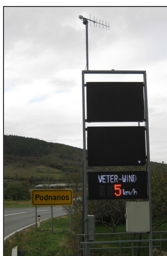
Slika 18: Prikaz spremenljivih znakov za obveščanje uporabnikov v sistemu Burja - DRSC
