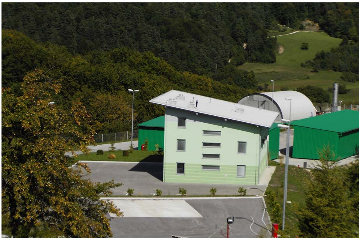
Slika 5: Obratovalna stavba na Regijskem odlagališču Unično (CEROZ)
