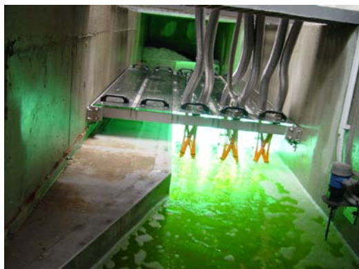
Slika 34: UV reaktor z delujočimi svetili – ČN Radovljica (MAK CMC, 2006)
