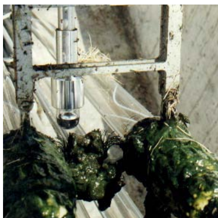
Slika 39: Vpliv avtomatskega čiščenja na čistočo stekel UV svetil
