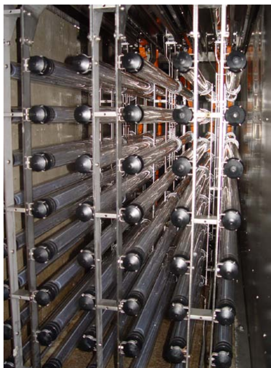
Slika 47: ČN Radovljica – UV reaktor (MAK CMC, 2006)
