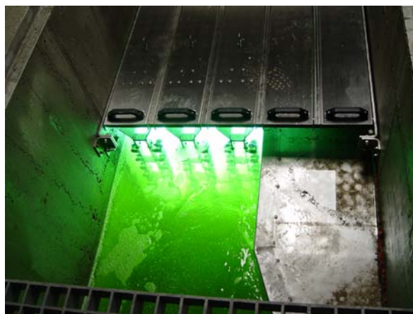
Slika 48: ČN Radovljica – UV reaktor v obratovanju (MAK CMC, 2006)
