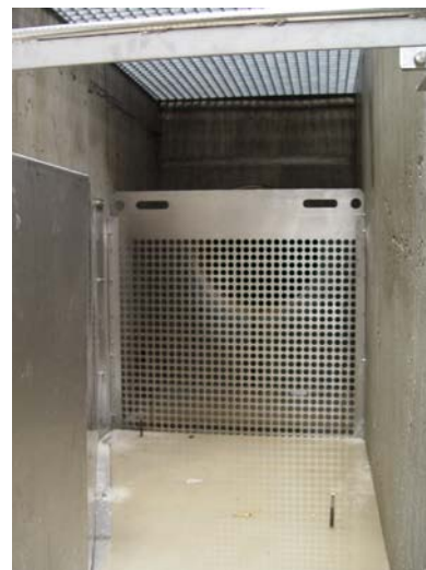
Slika 32: Primer umirjevalne rešetke – ČN Radovljica (MAK CMC, 2006)
