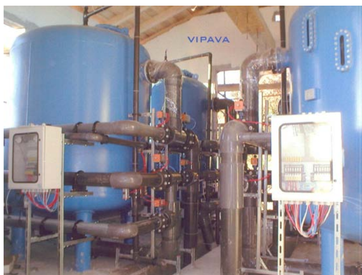
Slika 49: Vodarna Vipava – tlačni filtri (MAK CMC, 2005)
