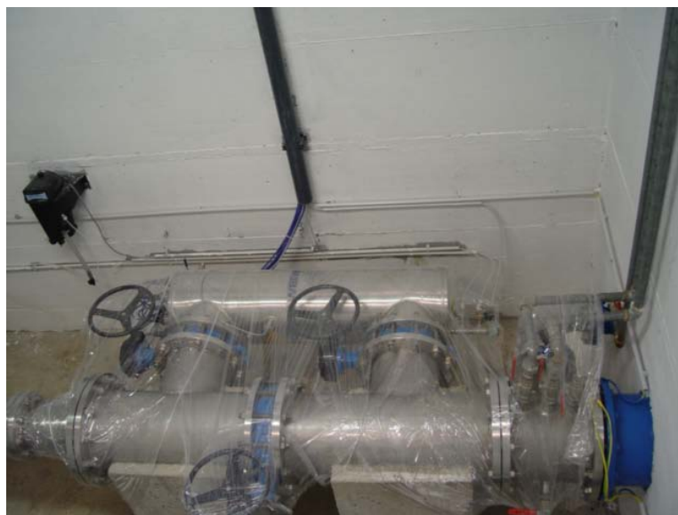
Slika 50: Vodarna Vipava – UV reaktor (MAK CMC, 2005)
