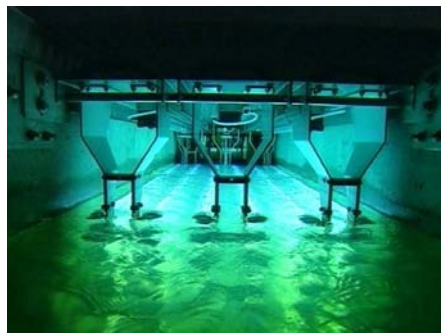
Slika 22: UV reaktor pri toku s prosto gladino (ITT WEDECO, 2008)
