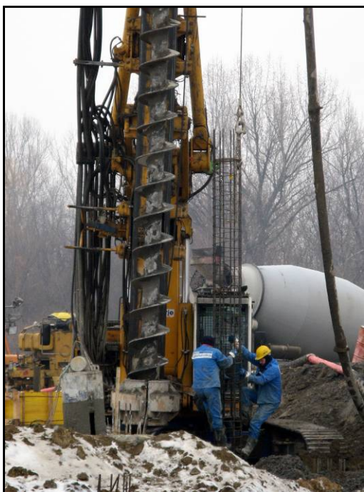
Slika 3.12: Ročno vtiskanje armature
