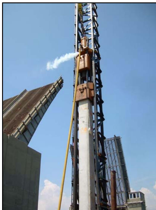
Slika 2.14: Zabijanje betonskega pilota
