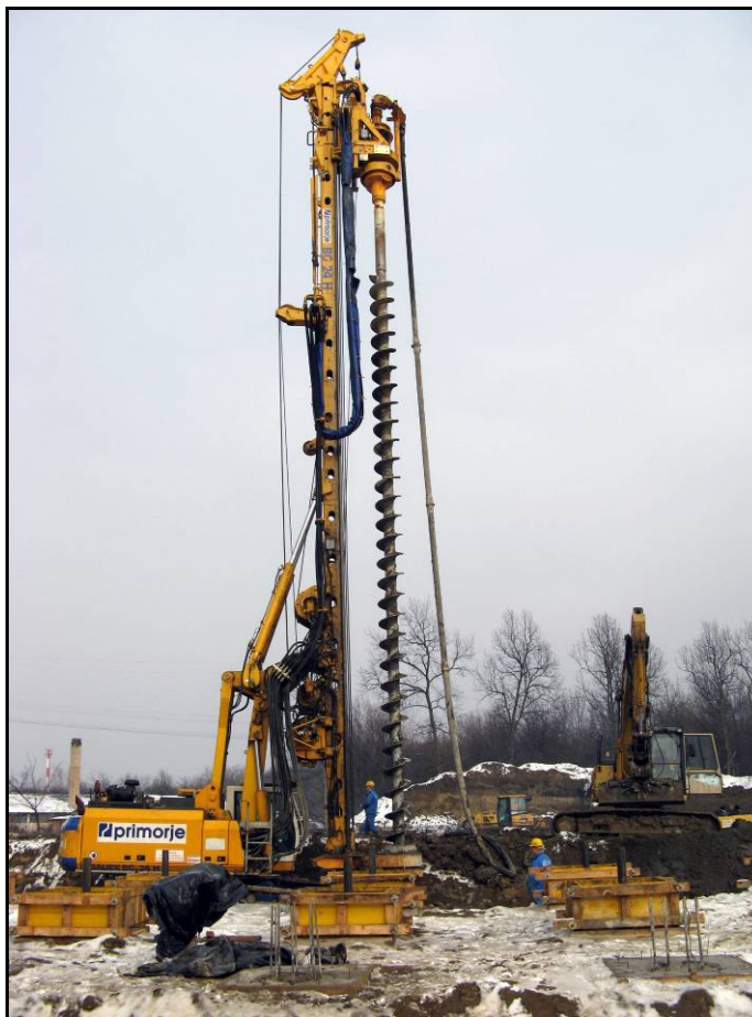
Slika 3.1: Vrtalni stroj s CFA opremo
