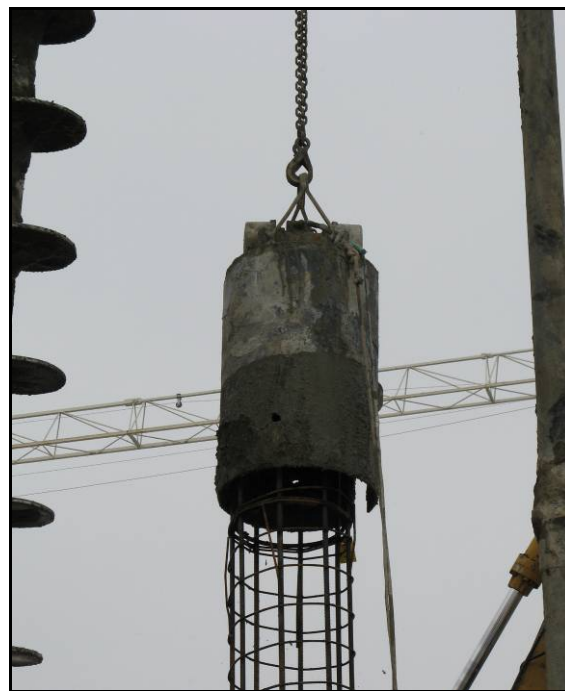
Slika 3.13: Vtiskanje armature z vibratorsko glavo
