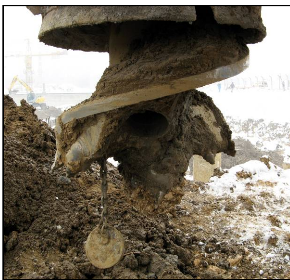
Slika 3.7: Zaključek cevi za betoniranje s čepom
