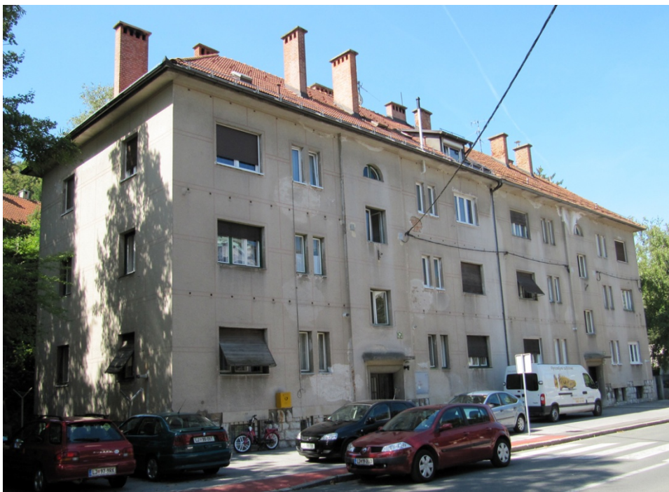
Slika 47: Fotografija obravnavane zgradbe iz leta 1937
