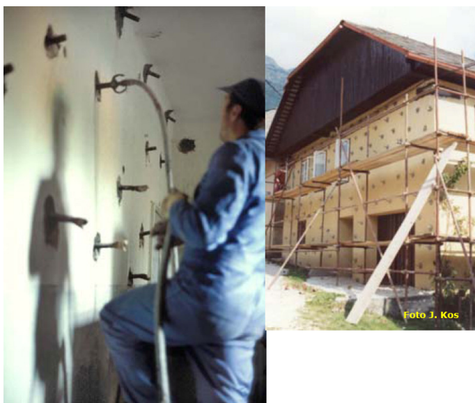
Slika 4: Injektiranje razpok (Tomažević, 2007)
