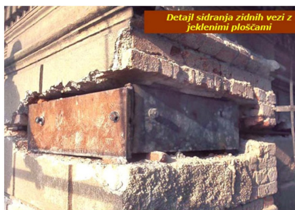
Slika 10: Detajli izvedbe jeklenih vezi
