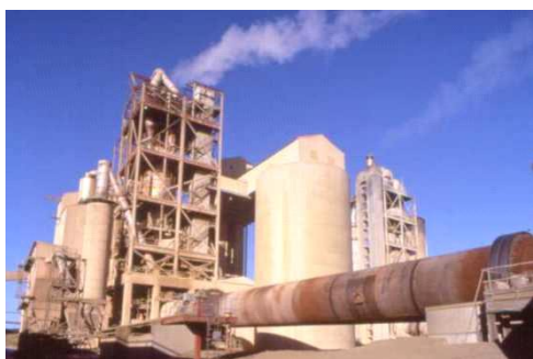
Slika 1: Rotacijska peč in cementni grad [1]
