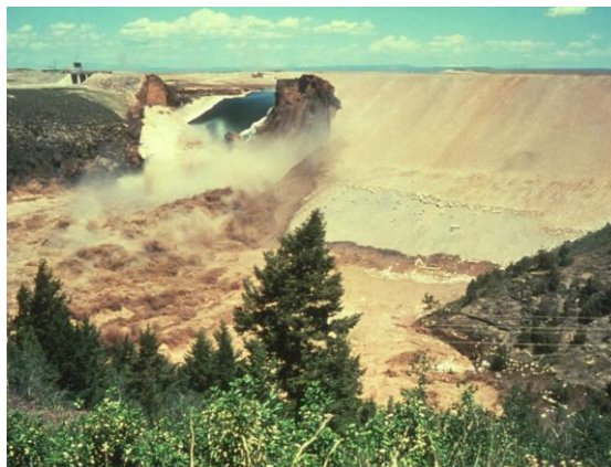
Slika 3.12: Porušitev zemeljske pregrade – Teton dam, kot posledica notranje erozije. (Vir: web.mst.edu.)
