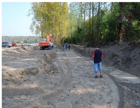
Slika 5.20: Priprava temeljnih tal. (Vir: Laboratorij KMTal.)
