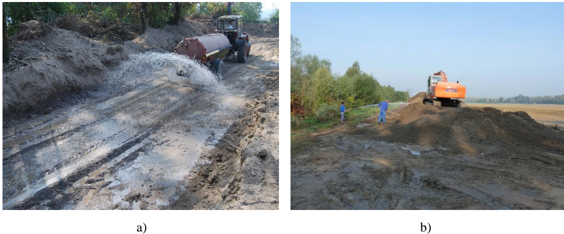
Slika 5.21: a) vlaženje temeljnih tal s pomočjo cisterne za vodo (Vir: Laboratorij KMTal.), b) vlaženje materiala na začasni deponiji.
