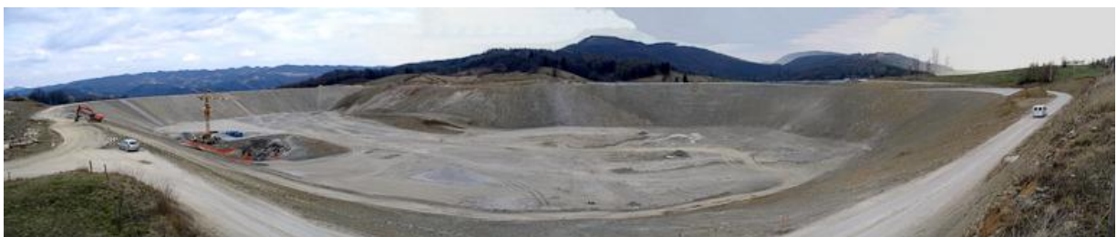
Slika 3.1: Akumulacija črpalne HE Avče je ustvarjena z dvema do 25 m visokima nasipoma.
