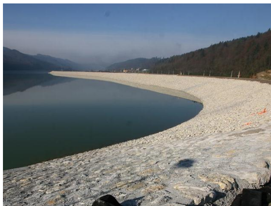
Slika 3.3: Nasip za akumulacijo vode za HE Blanca. (Vir: www.hes.si .)
