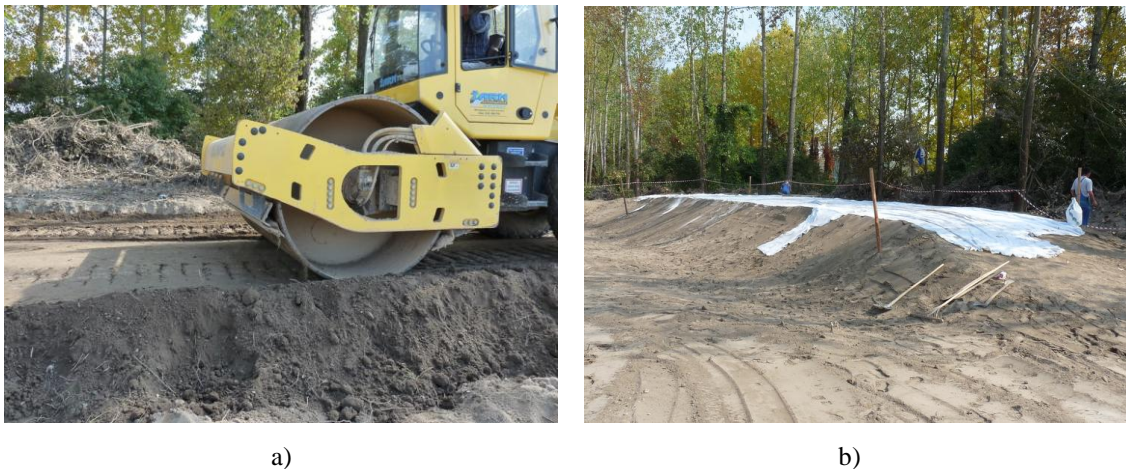
Slika 5.22: a) zgoščanje nasipnega materiala z vibracijskim valjarjem, b) končna podoba poskusnega nasipa.
