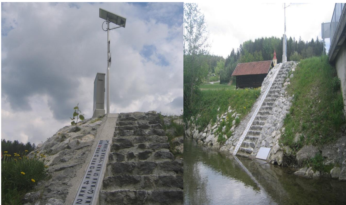
Slika 24: Avtomatska vodomerna postaja Gaberke (foto: Stanjko, 2015)
