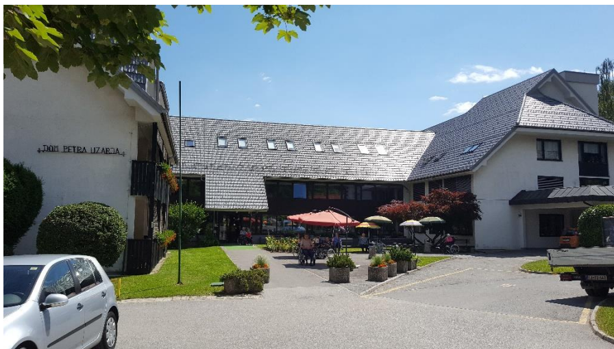
Slika 5: Pogled s severne strani (po sanaciji strehe)
