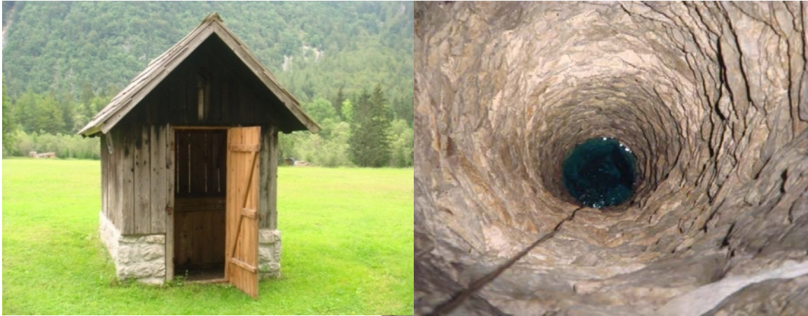
Slika 19: Objekt, v katerem je vodnjak z vgrajenim inštrumentom
