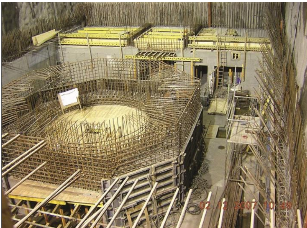
Slika 58: Notranjost podzemne zgradbe elektrarne med gradnjo turbinske hale (vir: Bollfilter John..., 2015)
