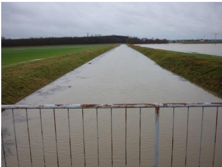
Regulirani vodotoki ob visokih vodah hitro odvedejo vodo. Ledava in poplavljeno zaledje.
