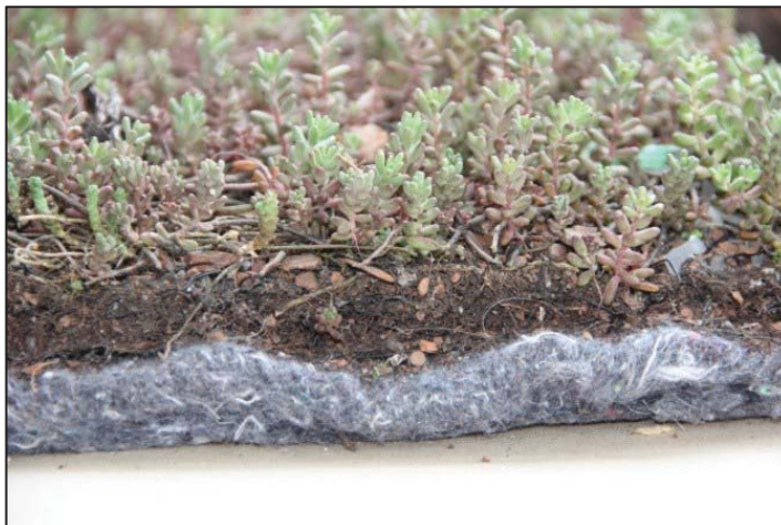
Slika 6: Sestava strehe 1 (vegetacija s substratom in filc) (Vir: avtor)
