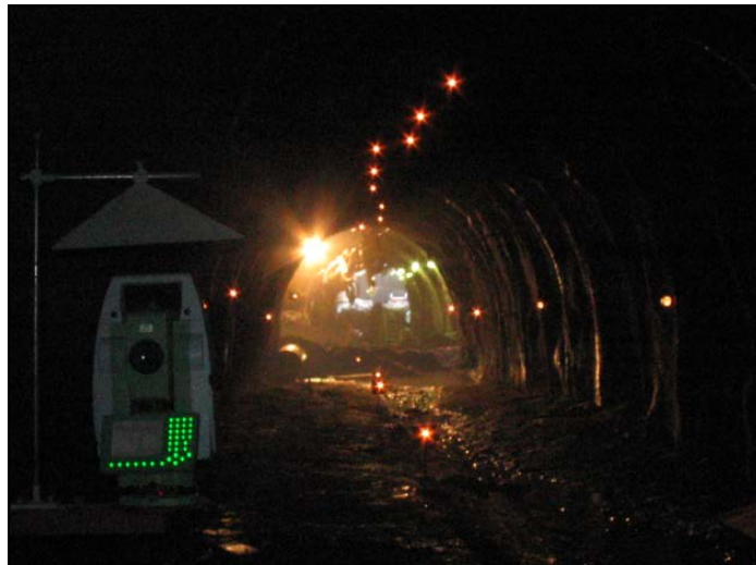
Slika 10: Pogled iz raziskovalnega rova proti čelu glavnega predora
