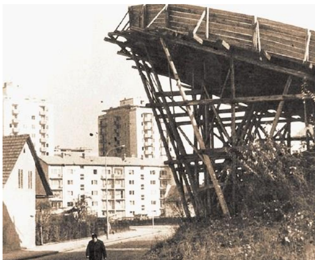
Slika 2: Iztek skakalnice nad Vodnikovo cesto
