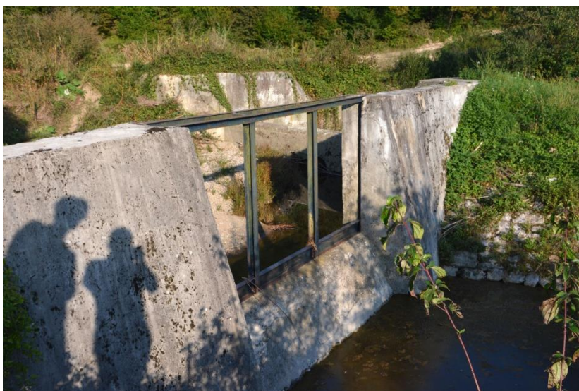
Slika 20: Razdelilni objekt, desno razbremenilnik, naravnost Ložnica (Skok, 2016).
