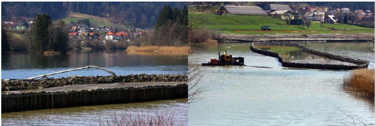
Slika 18 Prikaz črpanja rečnega sedimenta na območju umetnega otoka in prikaz gradnje umetnega otoka in oblikovanje brežin z uporabo rečnega sedimenta [18]
