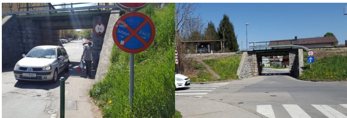
Slika 8 - Pogled na prehod 3 iz obeh smeri
