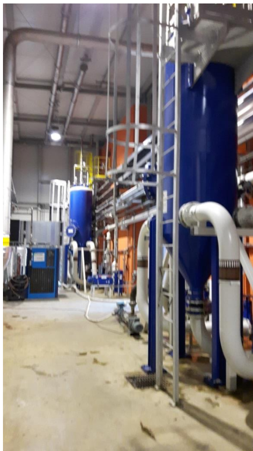
Slika 27: Praznjenje fermenterjev - zbiralnik 541B20 [vir: lasten]
