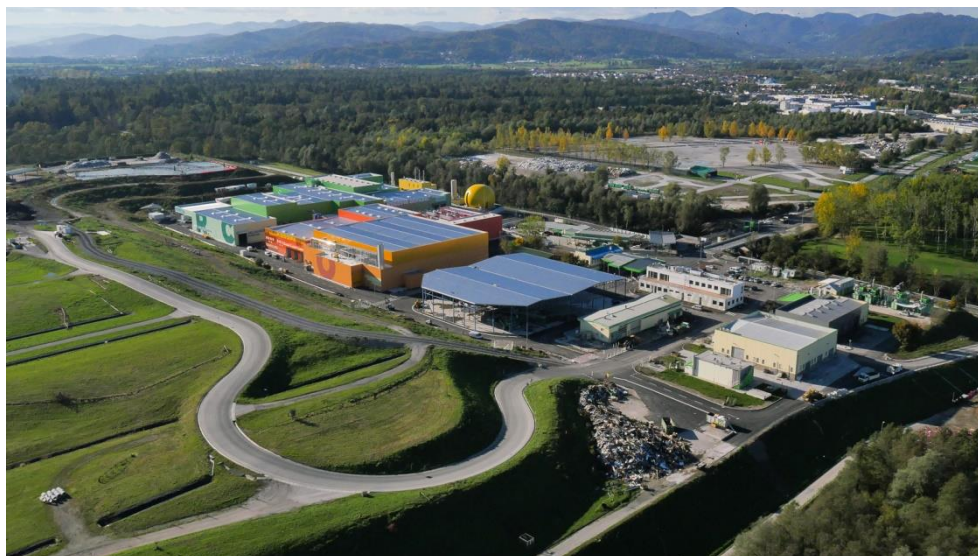
Slika 2: Pogled na RCERO in čistilno napravo [vir: Strabag]
