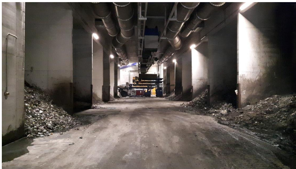
Slika 30: Tuneli za stabilizacijo in stroj za avt.polnjenje 650X40 [vir: lasten]
