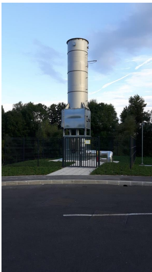
Slika 39: Varnostna bakla 670D20 [vir: lasten]
