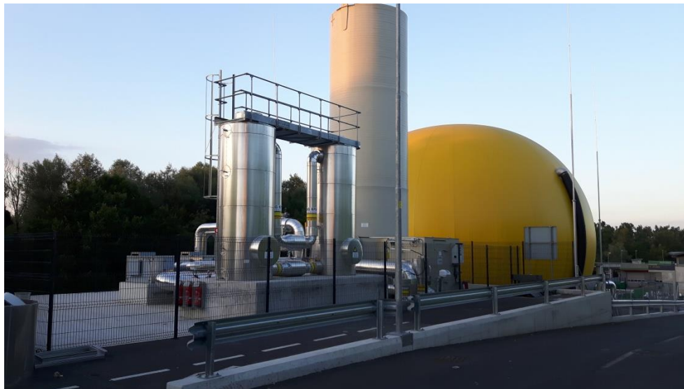
Slika 36: Plinohram 670B10, razžvepljevalnik 670X30, filtra z aktivnim ogljem 670F41, 670F42 [vir: lasten]
