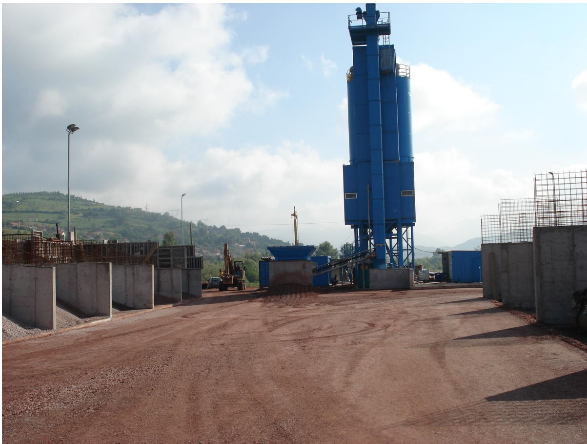
Slika 7: Začasna betonarna in boksi za frakcije
