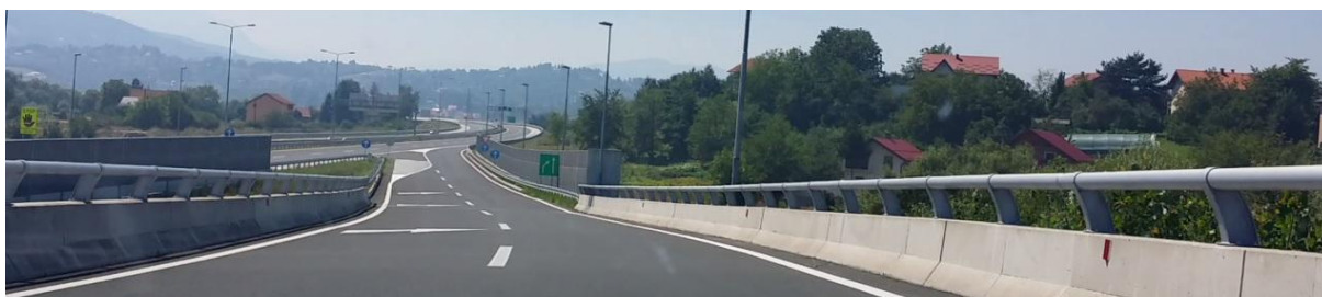
Slika 21: Razcep Butila; priključni nasip Rampa B (Sarajevo–Mostar)
