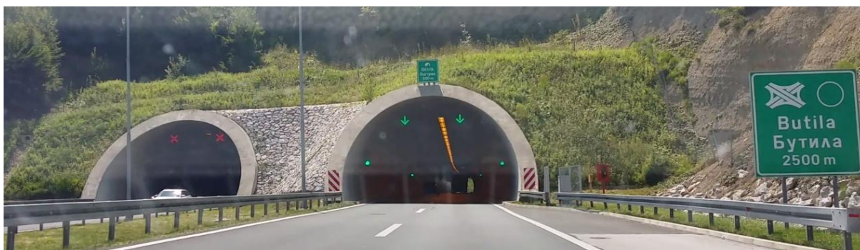
Slika 24: Predor Oštrik; Severni portal (Zenica–Mostar)
