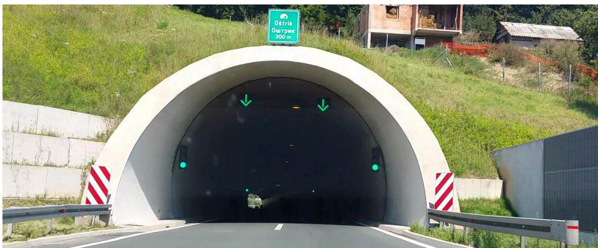
Slika 25: Predor Oštrik; Južni portal (Mostar–Zenica)
