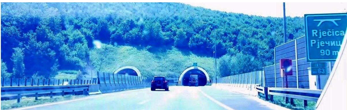
Slika 13: Viadukt Rječica (Zenica–Mostar)
