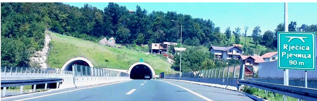
Slika 14: Viadukt Rječica (Mostar–Zenica)
