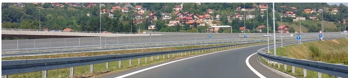
Slika 22: Razcep Butila; priključni nasip Rampa D (Sarajevo–Zenica)
