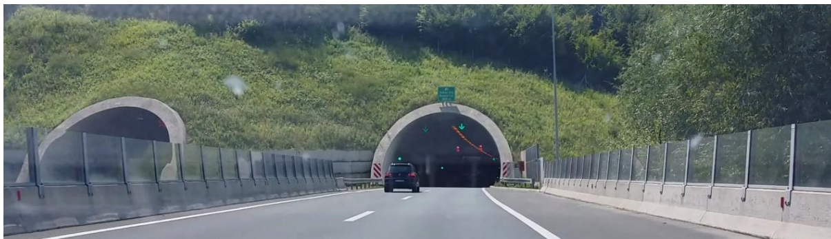
Slika 26: Predor Ožega; Severni portal (Zenica–Mostar)
