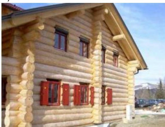
Slika 2: Sodobna kladna konstrukcija (Lesena gradnja)
