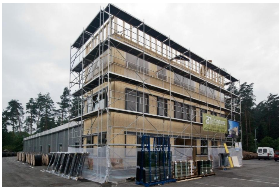
Slika 26: Poslovna stavba Eltima v času izgradnje (Cbd-Eltima)
