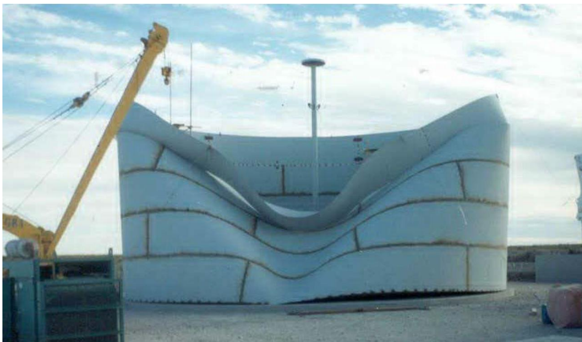
Slika 1.4: Uklon rezervoarja v fazi gradnje zaradi obtežbe vetra, ki je bil trikrat manjši od projektirane obtežbe, Patagonija, 2001 [4].
