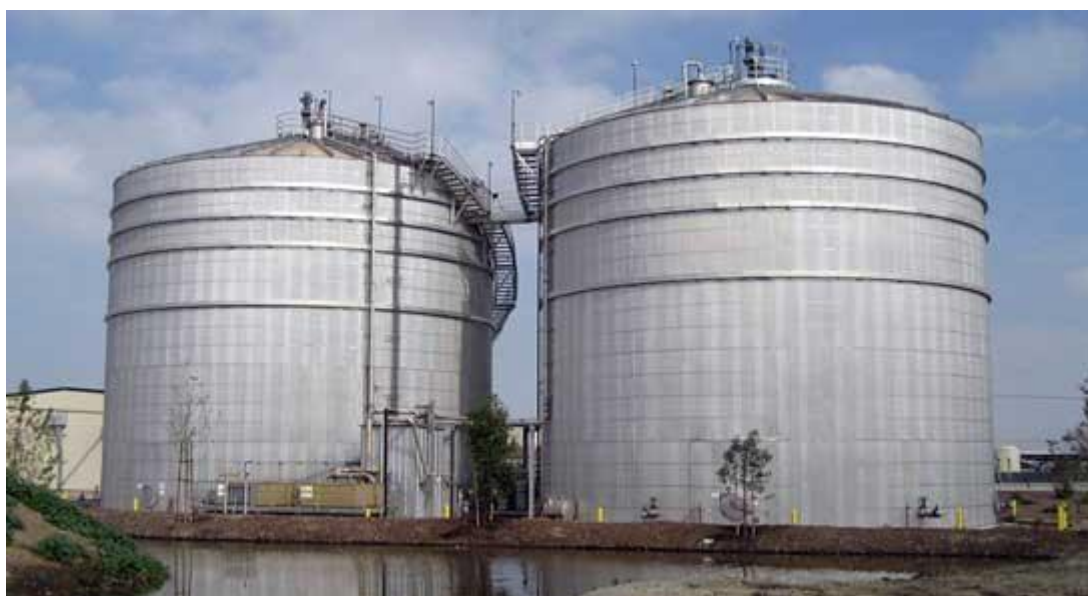
Slika 1.6: Primer horizontalnih ojačitev [6]
