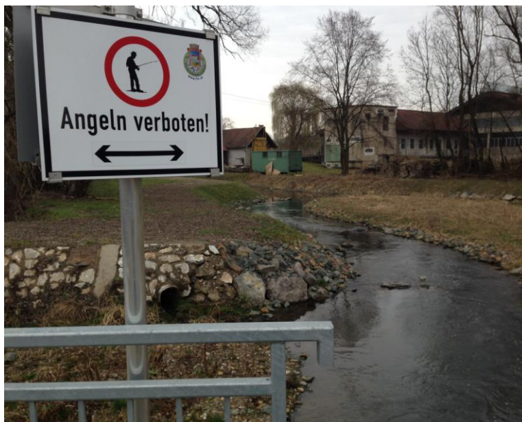
Slika 78: Prehod za vodne organizme, kjer je prepovedano loviti ribe, ob HE Gabersdorf, vir: posneto na licu mesta 12. 3. 2016
