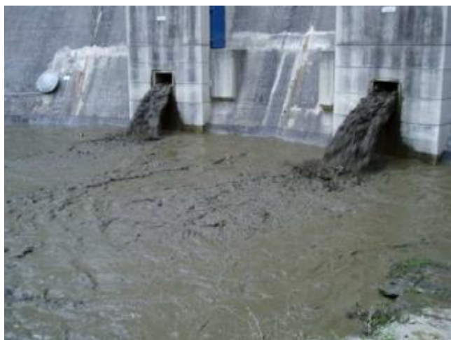
Slika 38: Občasno splakovanje zamuljenega dna v dolvodni del reke, HE Langmannsperre, vir: (Yumpu.com, 2006)
