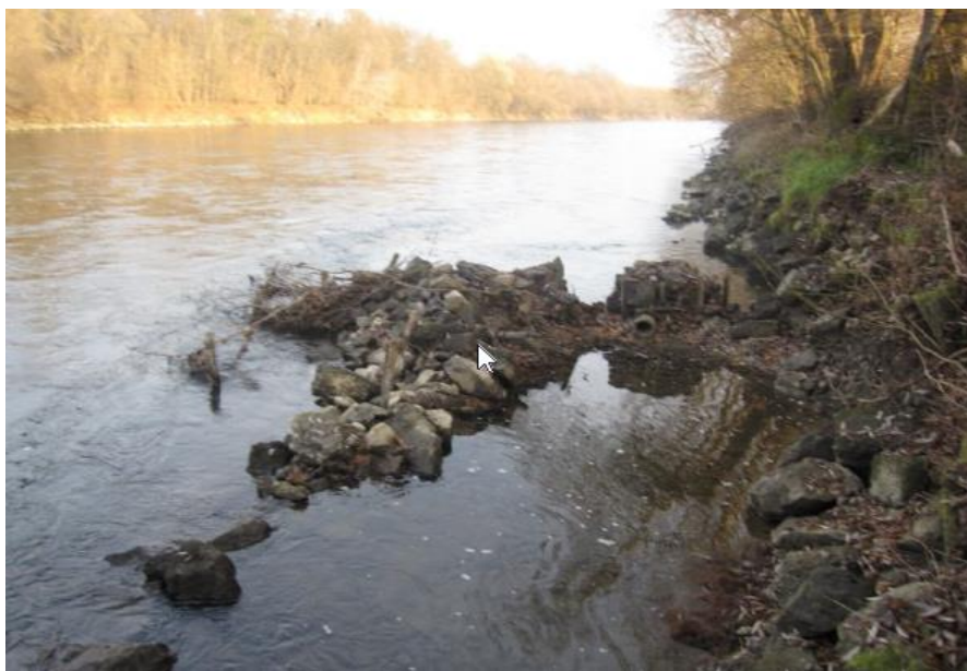
Slika 58: Stava na reki Muri narejena iz kamnov in lesa v zgornjem toku v Apačah, vir: Grilanc, J. 2010
