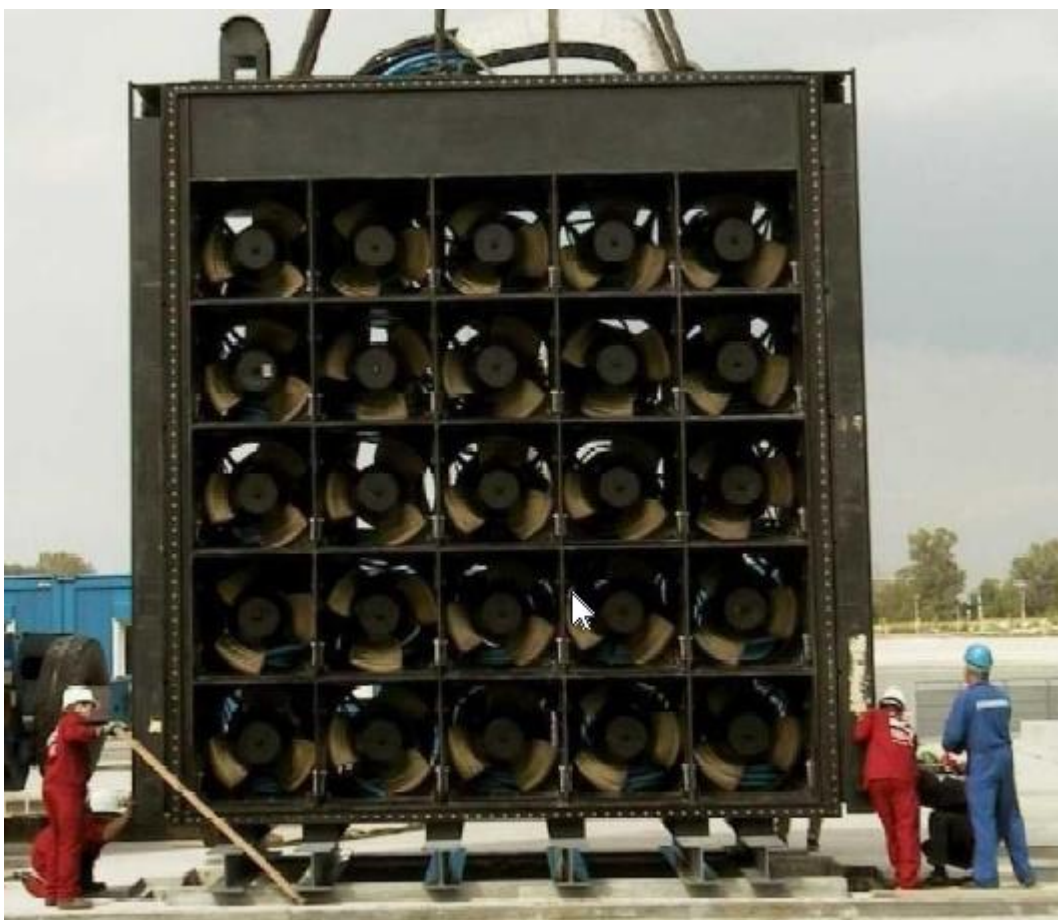
Slika 53: Primer Matrix turbine med gradnjo, vir: Grilanc J. 2010
