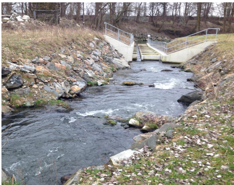
Slika 80: Prehod za vodne organizme z vmesnimi pregradami ob HE Gabersdorf, vir: posneto na licu mesta 12. 3. 2016
