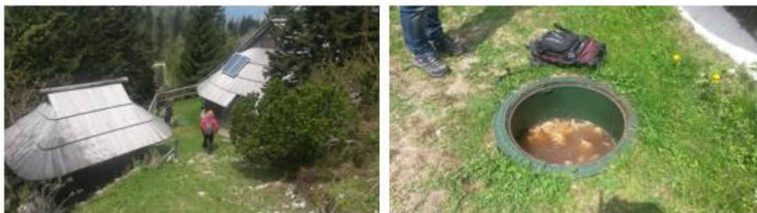
Slika 17: Koča na Veliki Planini opremljena z nepretočno greznico pojmeta GRAF, vir Občina Kamnik
