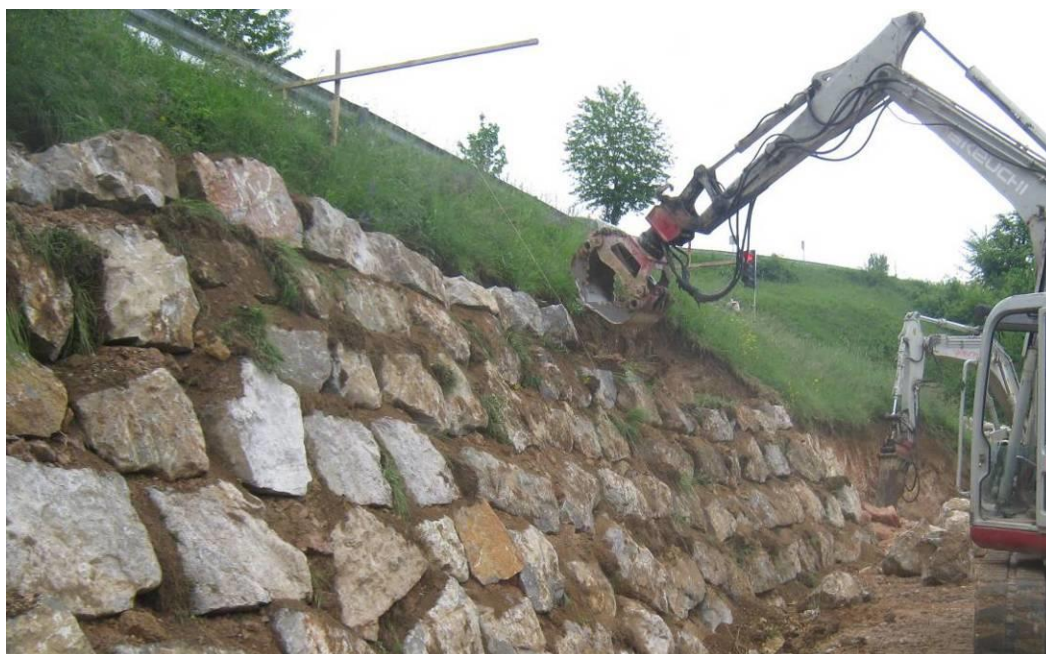
Slika 27: Izdelava suhe kamnite zložba ob levem robu vozišča – rolerana brežina (CGP, d.d., 2016)
