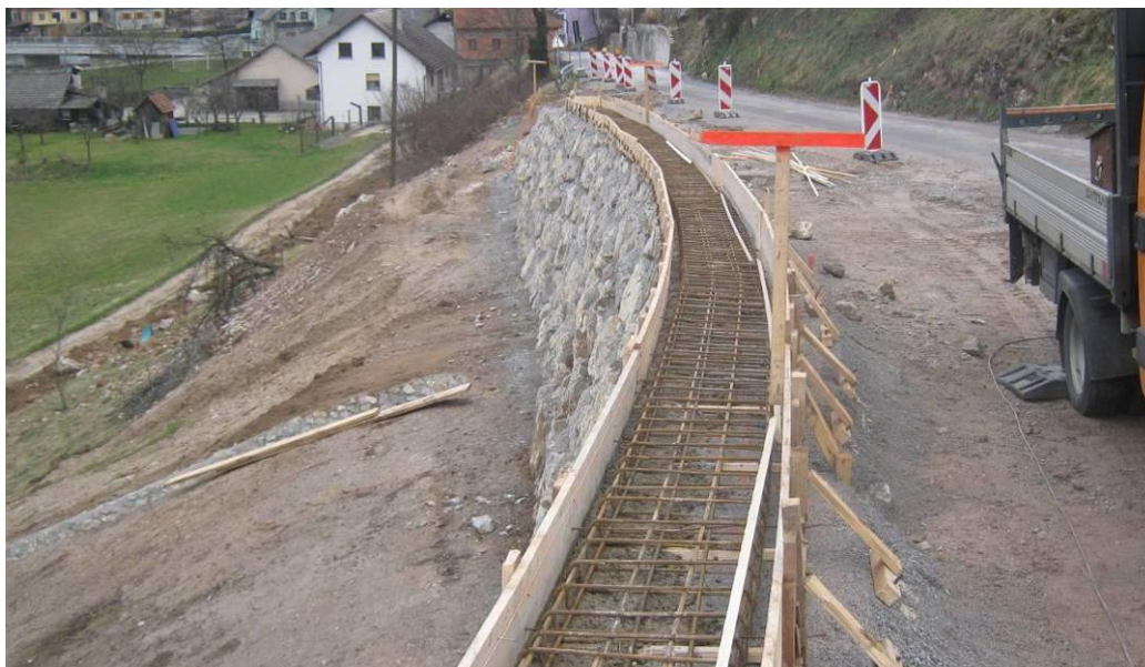
Slika 26: Armatura v vencu podpornega zidu (CGP, d.d., 2016)
