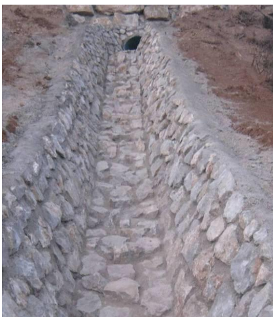
Slika 19: Kamnito betonsko trapezno korito in prikaz izliva meteorne kanalizacije (CGP, d.d., 2016)
