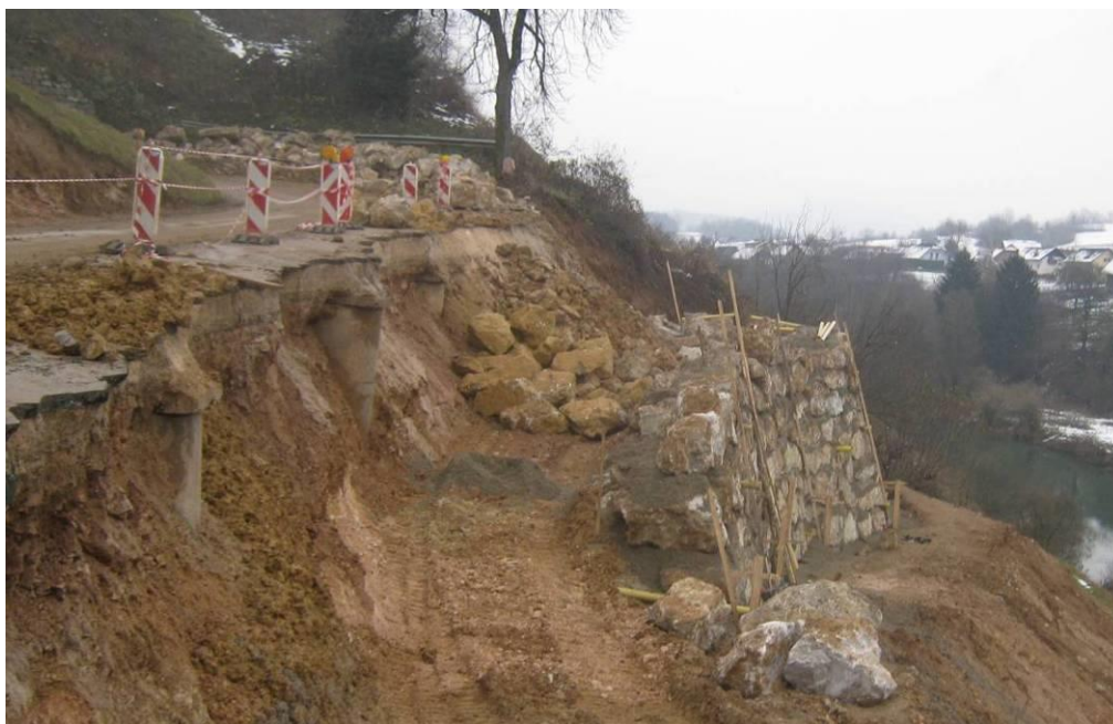
Slika 16: Izvedba kamnito-betonskega podpornega zidu B18-B21 (CGP, d.d., 2016)
