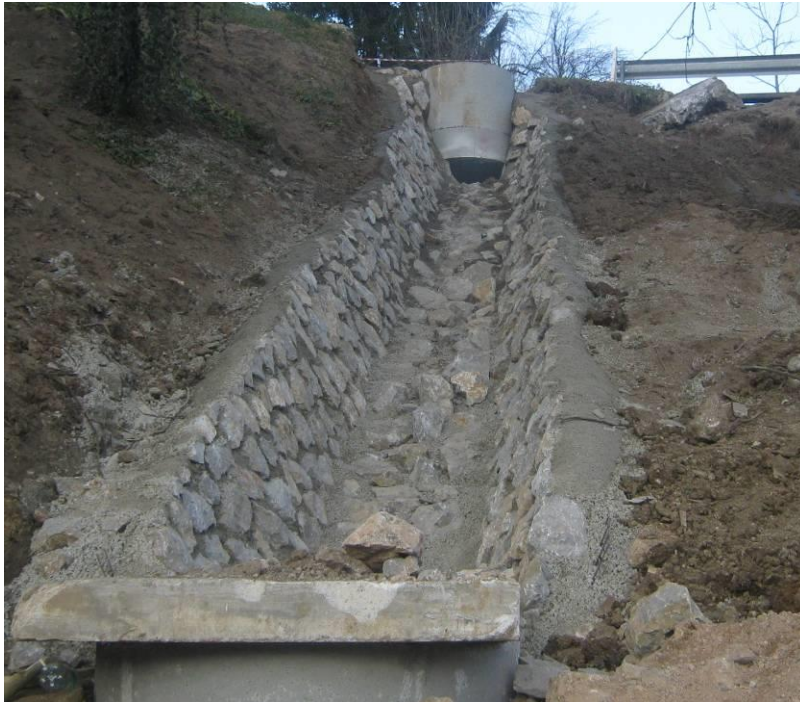
Slika 20: Izveden betonski revizijski jašek in obložen jarek z kamnom v betonu (CGP, d.d., 2016)
