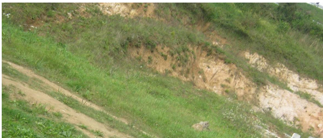
Slika 2: Plaz pod cesto, ki jo ogroža (CGP, d.d., 2015)
