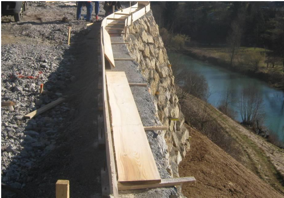
Slika 25: Opaženje venca podpornega zidu (CGP, d.d., 2016)
