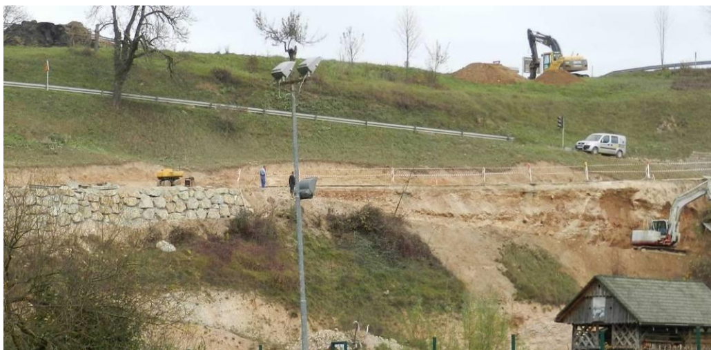
Slika 11: Izvedba kamnito-betonskega podpornega zidu P15-P18 in izkop za peto P18-P21 (CGP, d.d., 2016)
