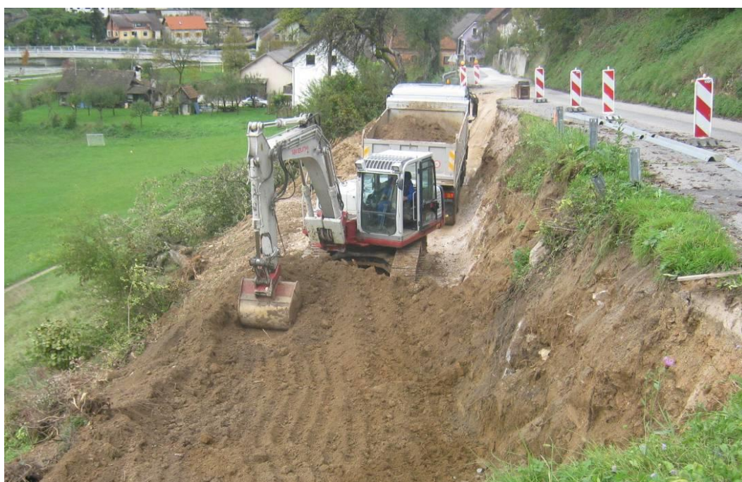
Slika 5: Izkop – priprava za izvedbo podpornih zidov B15-B18 (CGP, d.d., 2015)
