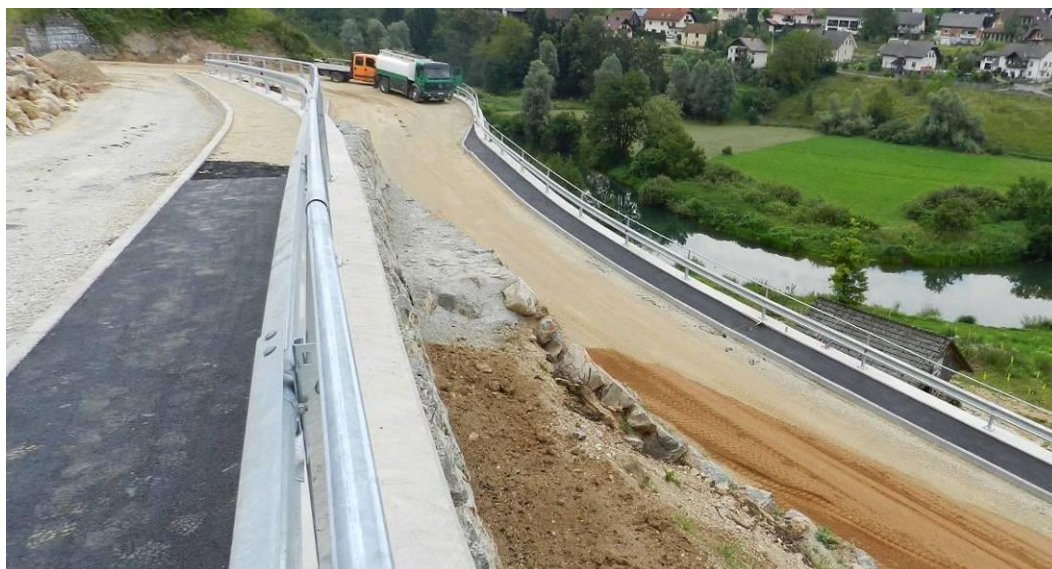
Slika 30: Asfaltiranje pločnikov in JVO ograja (CGP, d.d., 2016)
