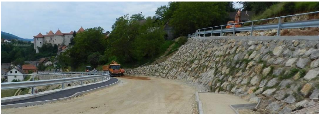
Slika 33: Izdelava finega planuma pred asfaltiranjem (CGP, d.d., 2016)
