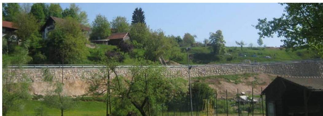
Slika 31: Podporni zid I. in II. faza z JVO ograjo (CGP, d.d., 2016)
