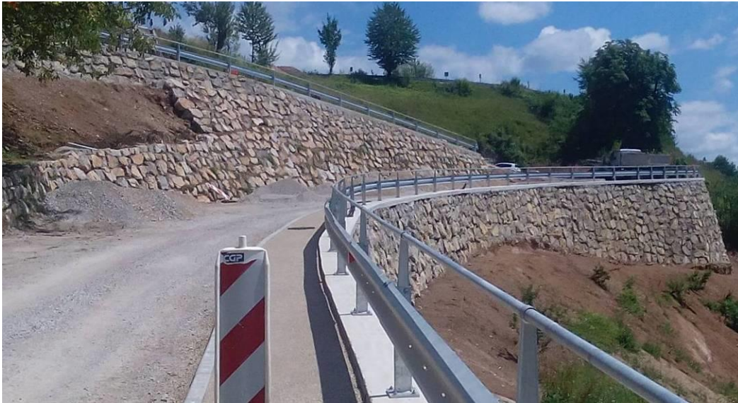
Slika 32: Kamnita betonska zložba in suha zložba pred asfaltiranjem (CGP, d.d., 2016)
