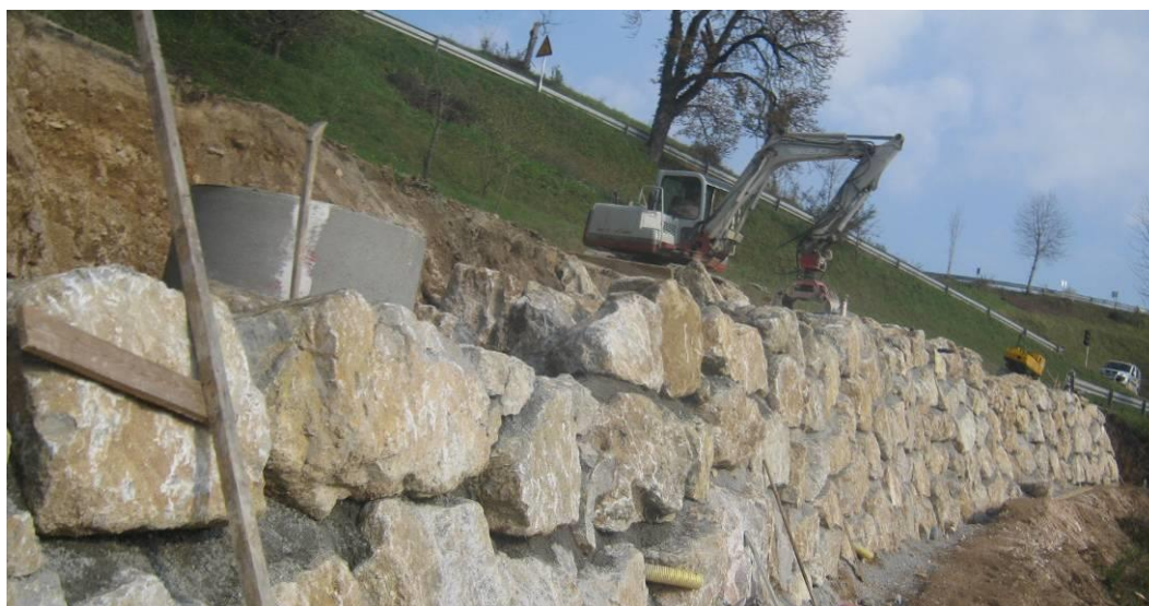
Slika 8: Izvedba kamnito betonskega podpornega zidu B15-B18 (CGP, d.d., 2015)
