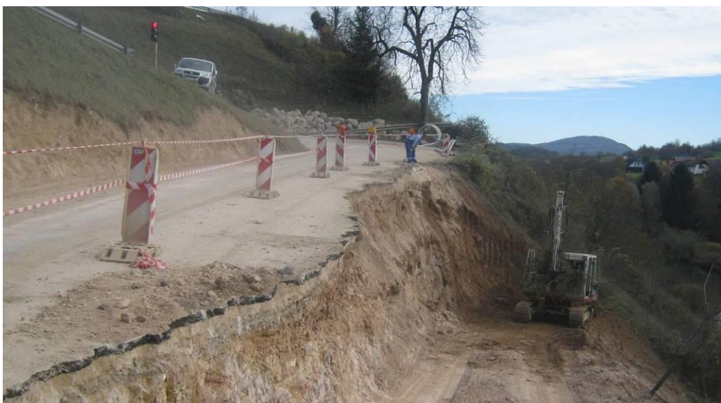
Slika 10: Izkop za kamnito peto podpornih zidov P18-P21 (CGP, d.d., 2016)
