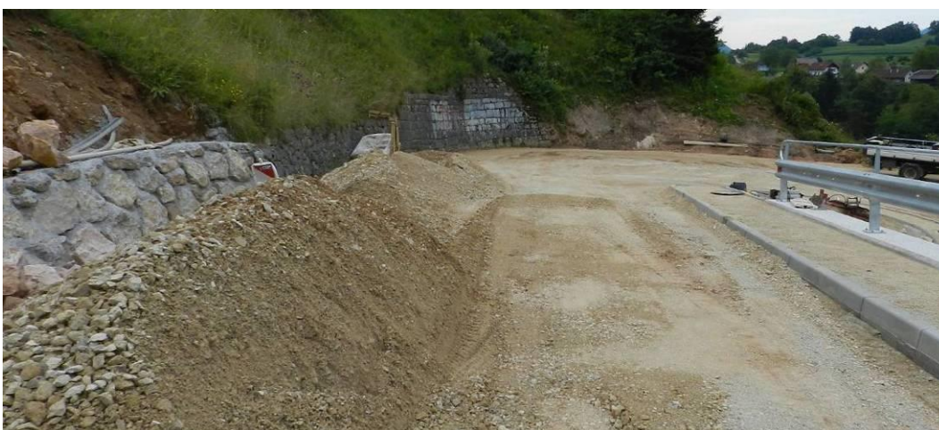
Slika 29: Vgrajevanje kamnitega materiala v zgornji ustroj (CGP, d.d., 2016)
