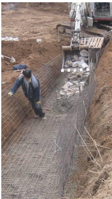
Slika 18: Izdelava armature za trapezno korito (CGP, d.d., 2016)
