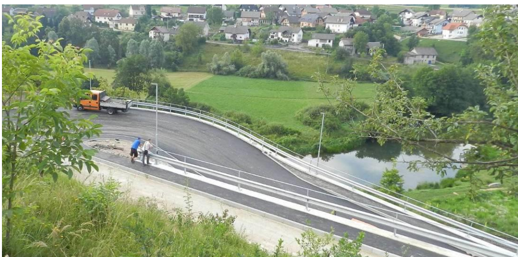
Slika 34: Asfaltirano vozišče (CGP, d.d., 2016)
