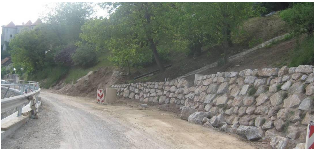
Slika 28: Suha kamnita zložba na levi strani vozišča (CGP, d.d., 2016)
