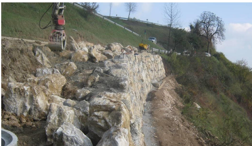
Slika 9: Izvedba kamnito-betonskega podpornega zidu B15-B18 (CGP, d.d., 2015)
