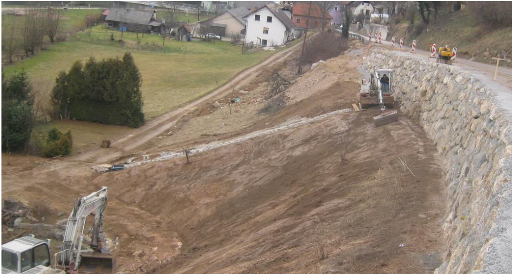
Slika 24: Planiranje pobočja pod kamnitim zidom (CGP, d.d., 2016)
