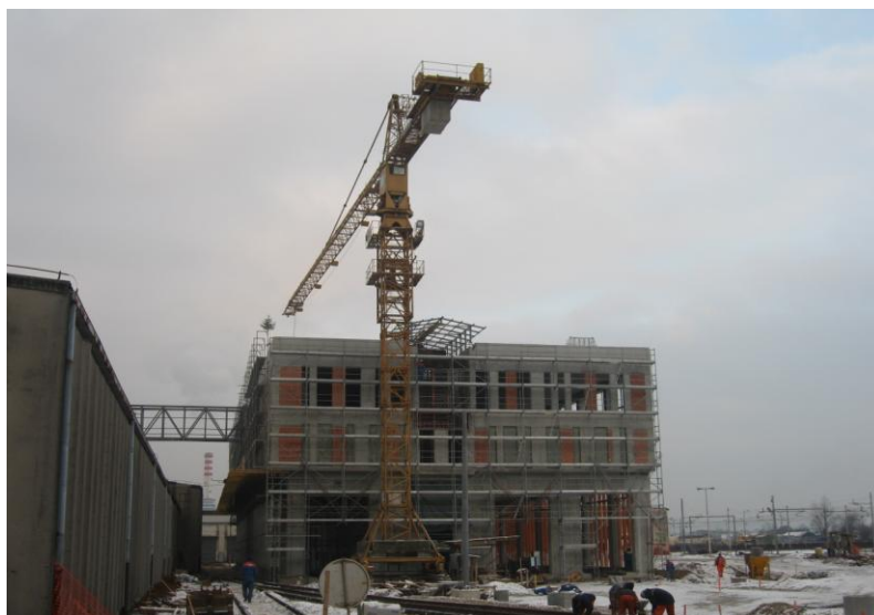
Slika 24: Primer žerjava na gradbišču (foto: Kumalić, 2009)
