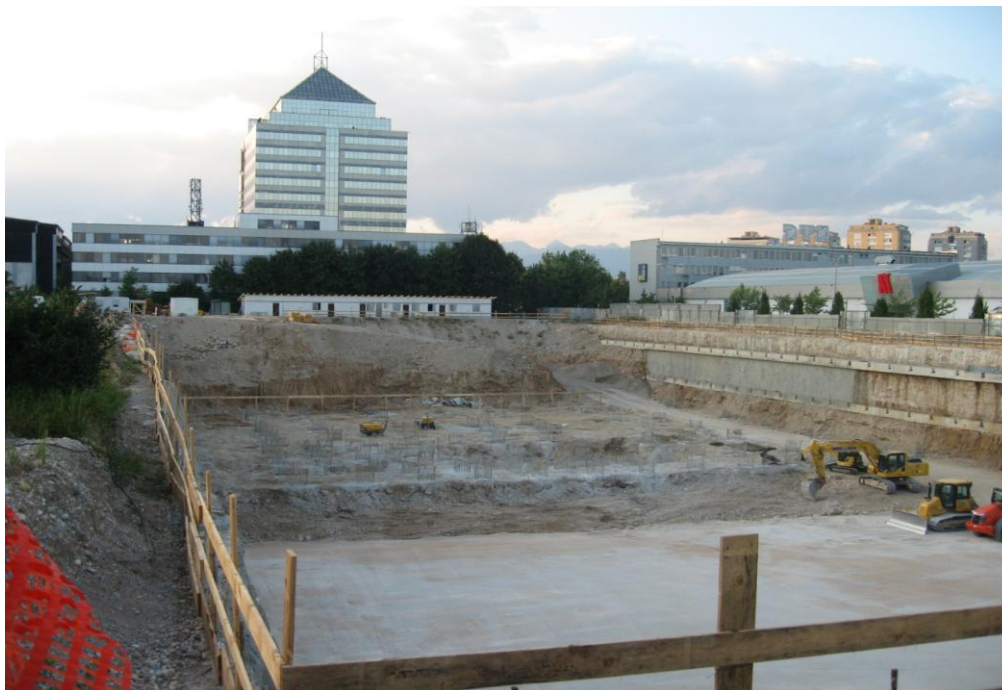
Slika 11: Izkop gradbene jame (foto: Kumalić, 2009)
