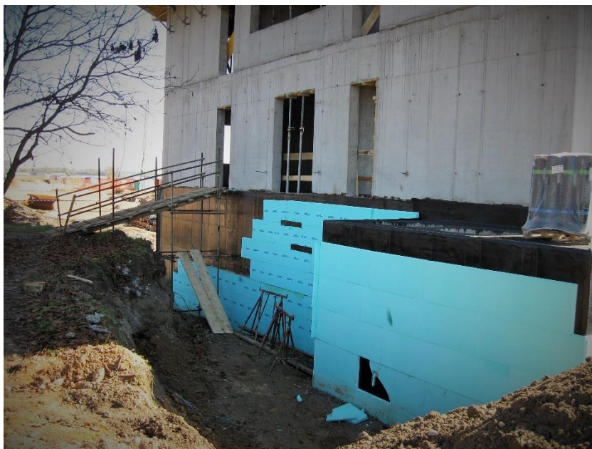
Slika 9: Detajl izvedbe HI in TI (vir: izvajalec)
