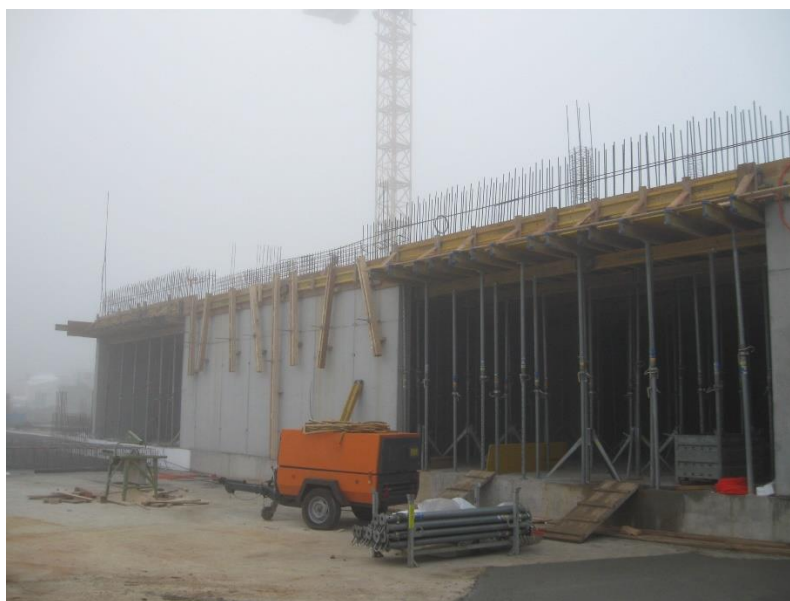
Slika 10: Opaž plošče pritličja (vir: izvajalec)
