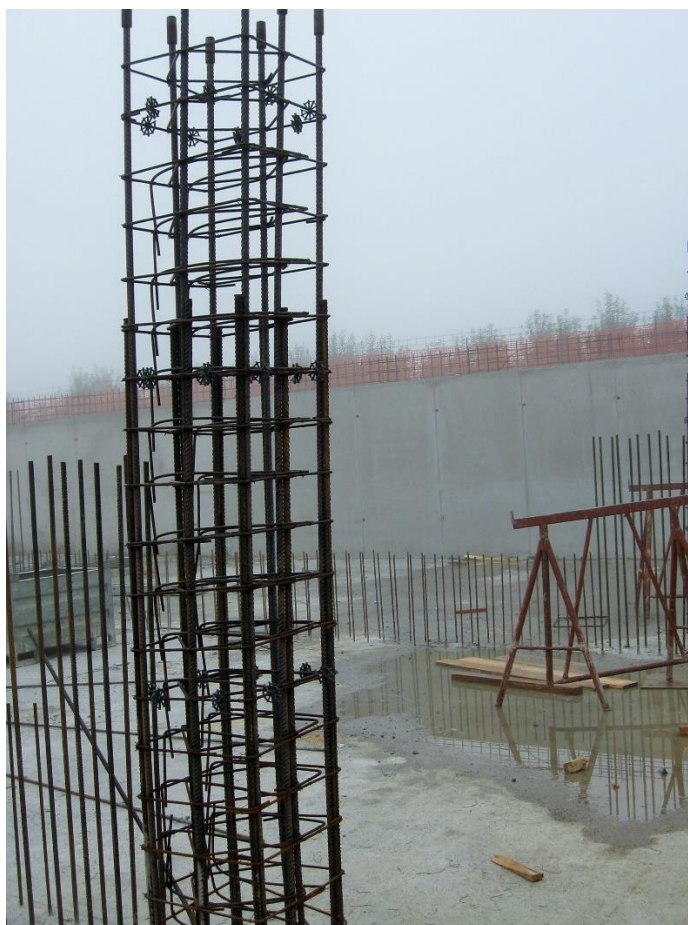
Slika 8: Detajl armature stebra (vir: izvajalec)
