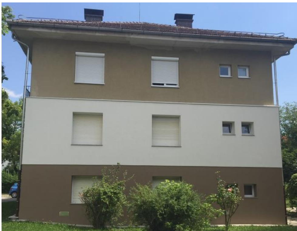
Slika 9: Zahodna stran bloka po obnovi
