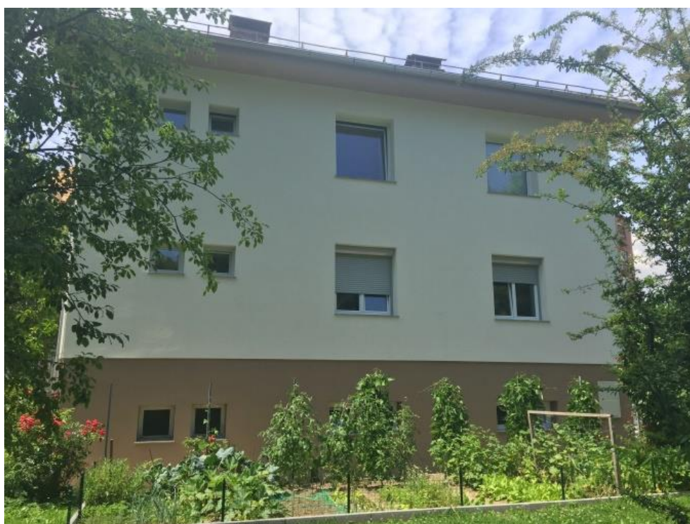
Slika 7: Vzhodna stran bloka po obnovi
