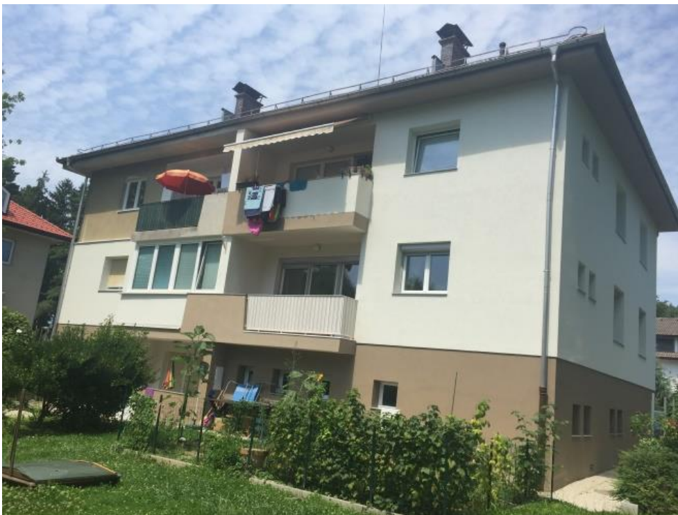
Slika 2: Južna stran bloka po obnovi
