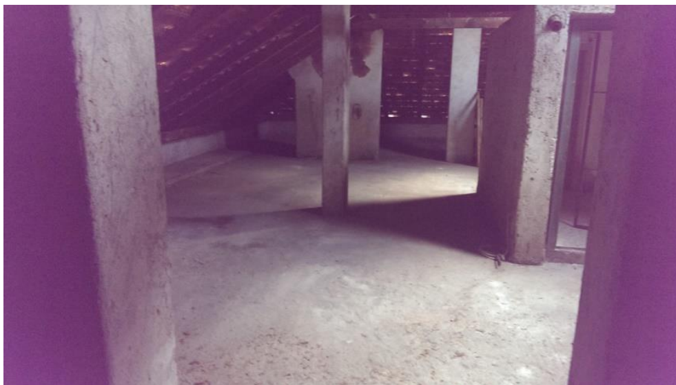
Slika 13: Podstrešje pred obnovo
