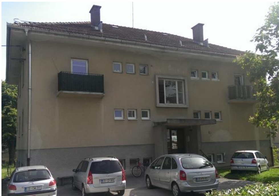
Slika 4: Severna stran bloka pred obnovo
