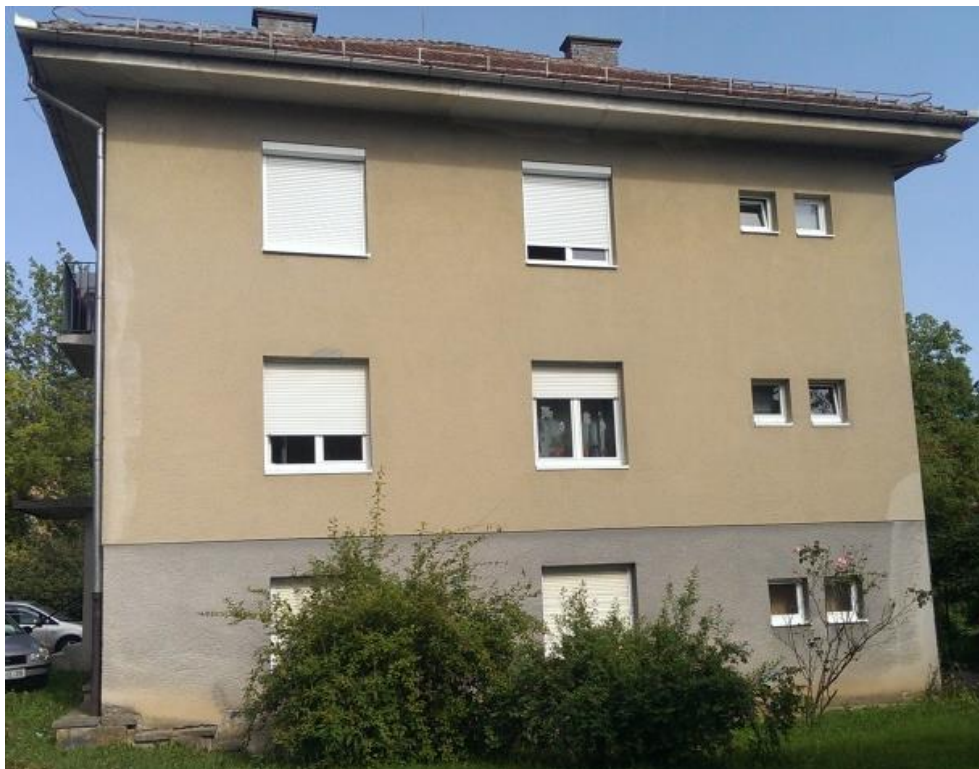
Slika 8: Zahodna stran bloka pred obnovo
