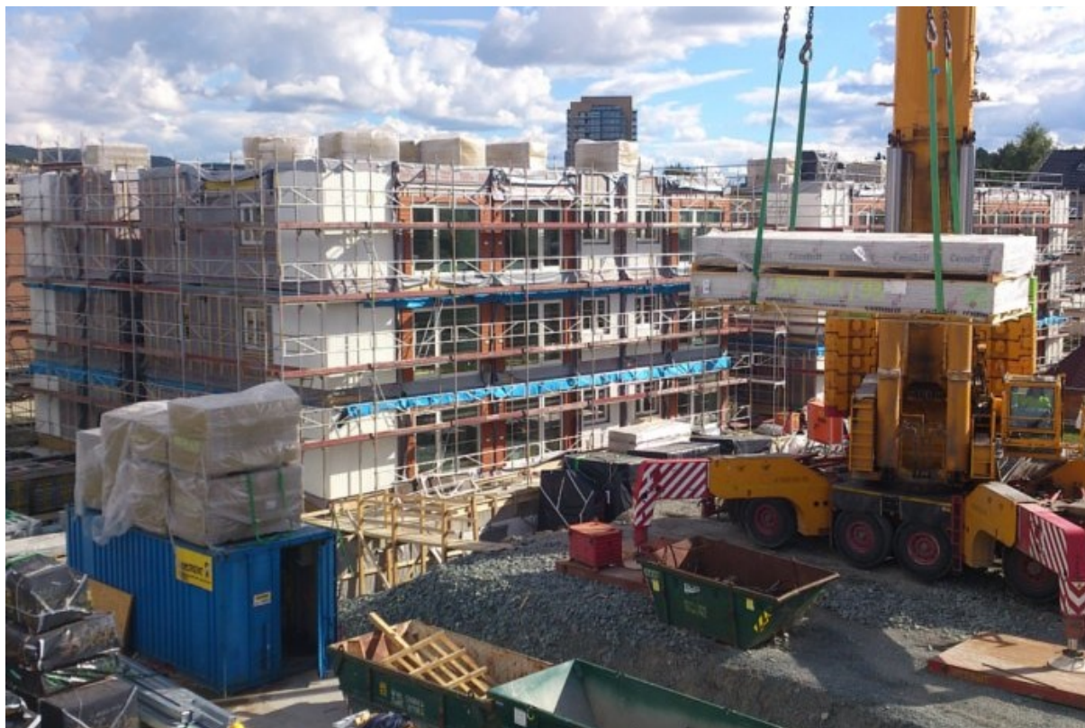
Slika 2: Gradnja modularne zgradbe na Norveškem [13]
