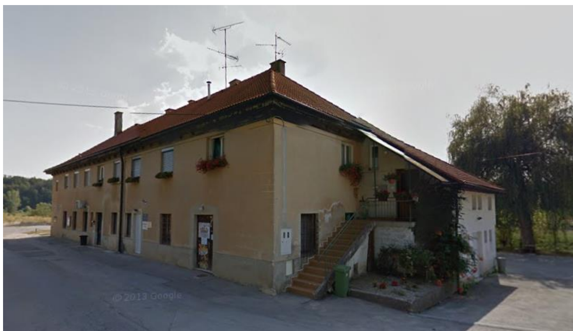
Slika 17: Obravnavani objekt pogled s ceste [21]
