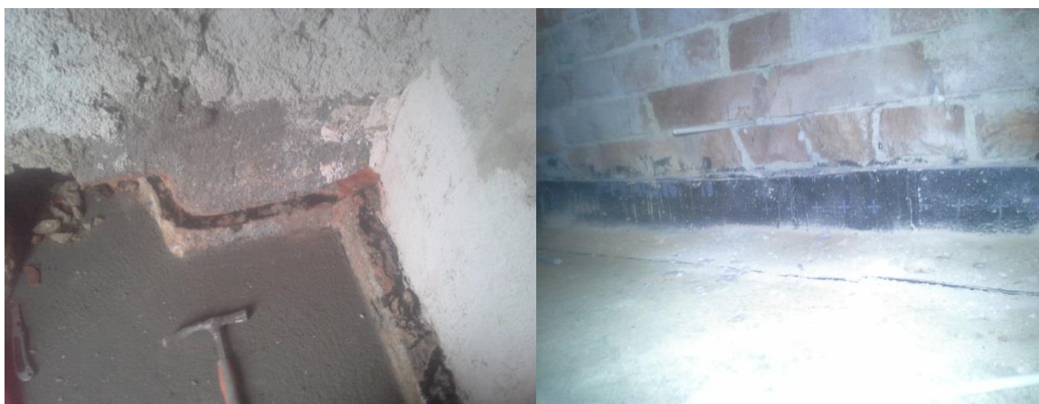
Slika 27: Očiščena obstoječa HI, ter izvedba spoja obstoječe HI ter nove HI [21]
