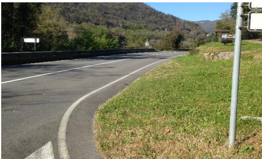
Slika 4.14: Preglednost v desno pri priključevanju z lokalne ceste na glavno cesto v območju križišča v km 1,730
