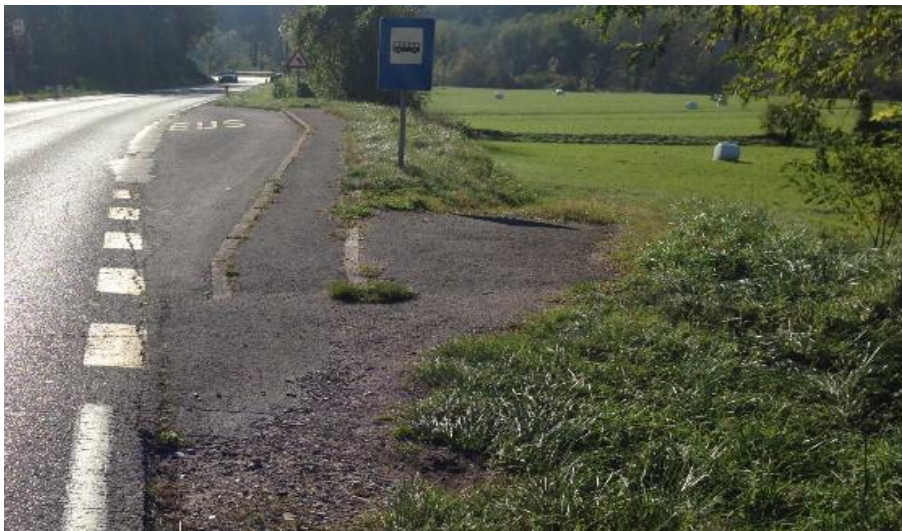
Slika 4.36: Priključek do obdelovalnih površin v km 1,350, pogled v nasprotni smeri stacionaže
