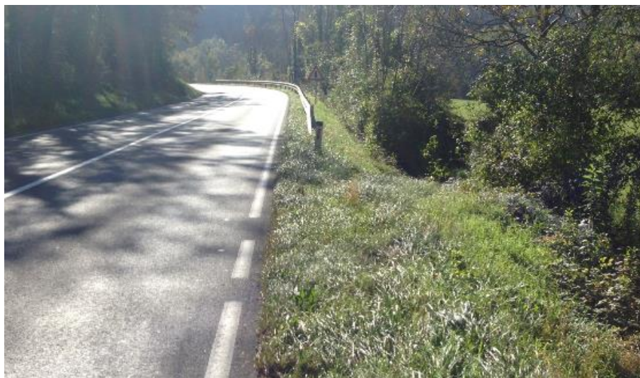
Slika 4.38: Priključek do obdelovalnih površin v km 1,430, pogled v smeri stacionaže
