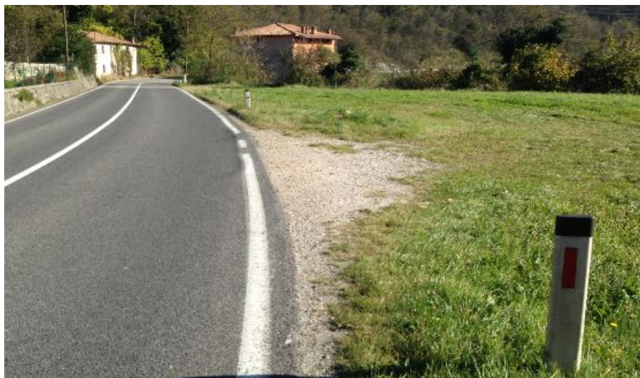
Slika 4.33: Priključek do travniških površin v km 0,200, pogled v smeri stacionaže
