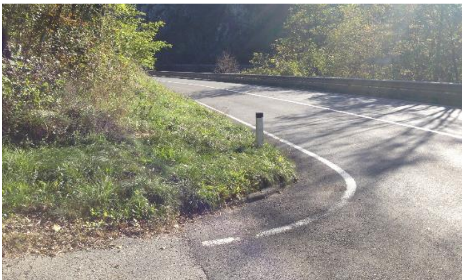
Slika 4.13: Preglednost v levo pri priključevanju z lokalne ceste na glavno cesto v območju križišča v km 1,730
