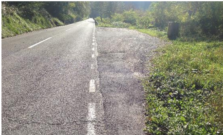
Slika 4.48: Počivališče od km 2,720 do km 2,750, pogled v smeri stacionaže
