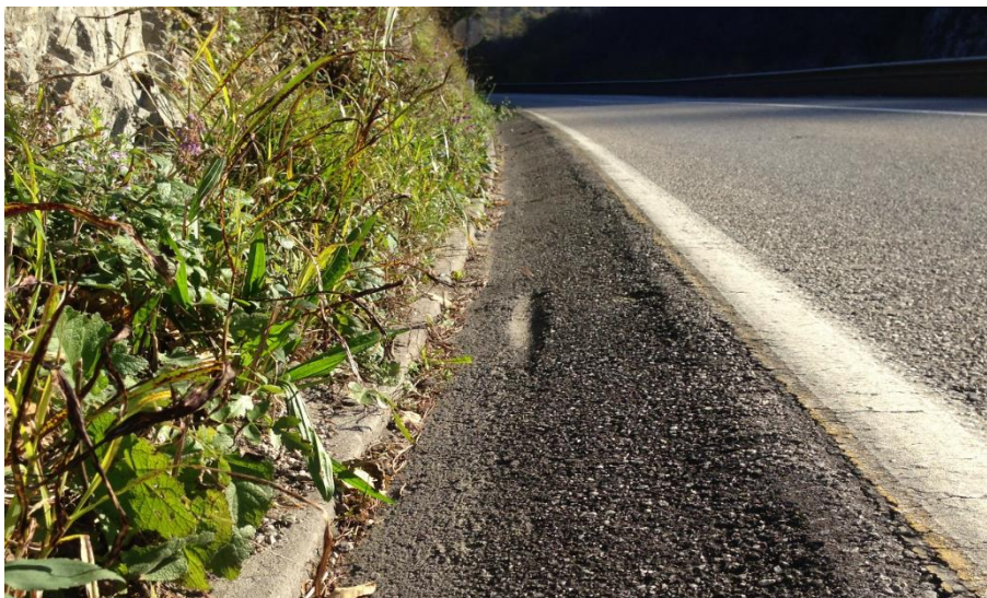
Slika 4.10: Prestrma koritnica od km 0,580 do km 0,750, pogled v smeri stacionaže
