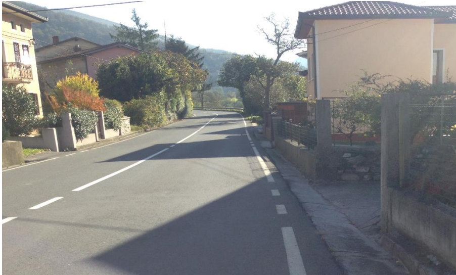
Slika 4.53: Manjkajoča cestna razsvetljava od km 0,000 do km 0,350, pogled v smeri stacionaže
