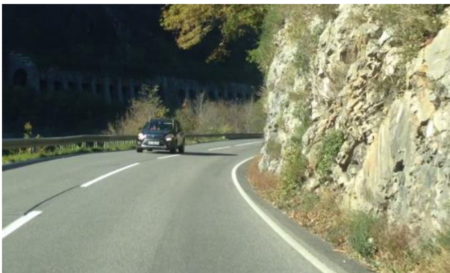
Slika 4.4: Nepregledna krivina od km 3,583 do km 3,686, pogled v nasprotni smeri stacionaže
