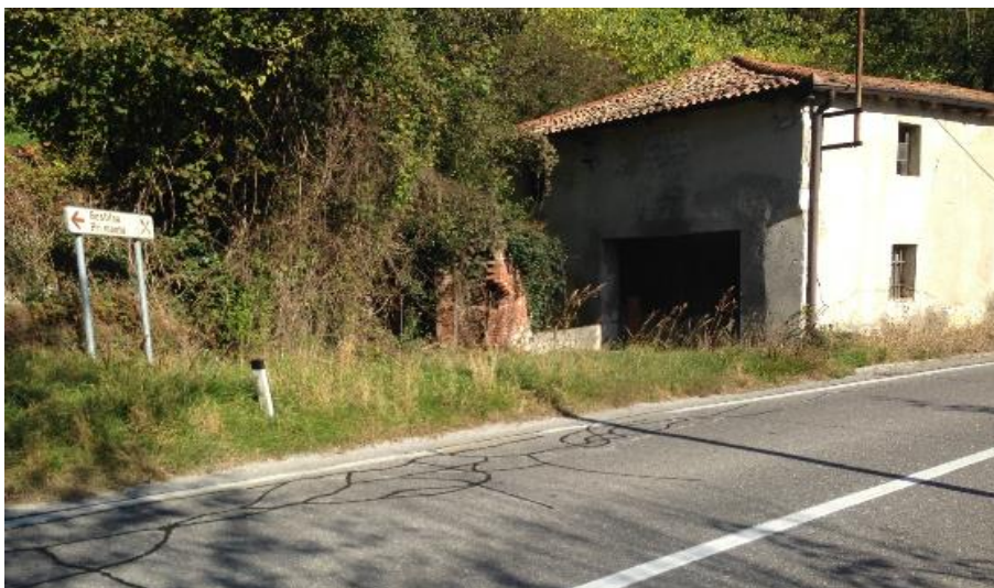
Slika 4.24: Priključek v km 0,270, pogled v smeri stacionaže
