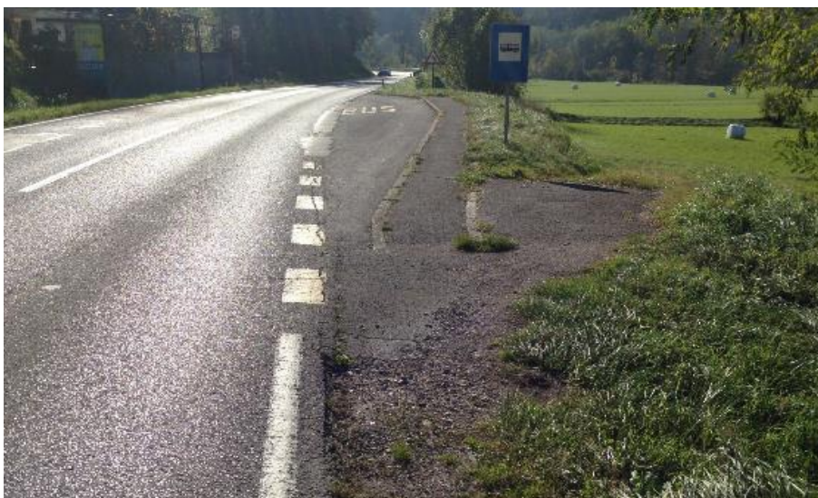
Slika 4.44: Avtobusno postajališče od km 0,350 do km 0,380, pogled v smeri stacionaže
