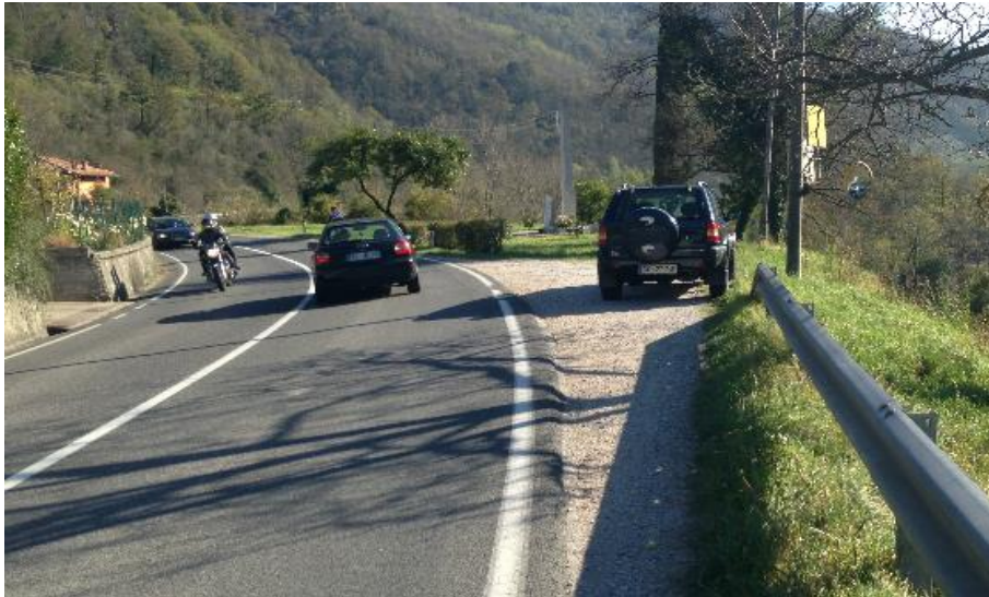
Slika 4.45: Počivališče od km 0,150 do km 0,170, pogled v smeri stacionaže
