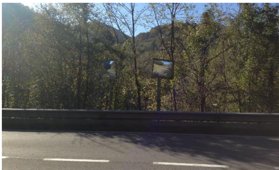
Slika 4.15: Prometna ogledala v območju križišča v km 1,730
