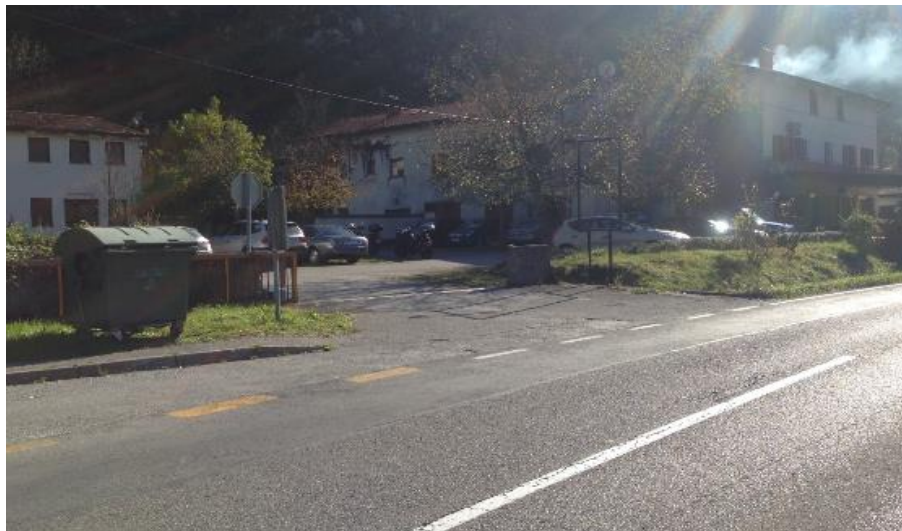
Slika 4.27: Priključek v km 1,340, pogled v smeri stacionaže
