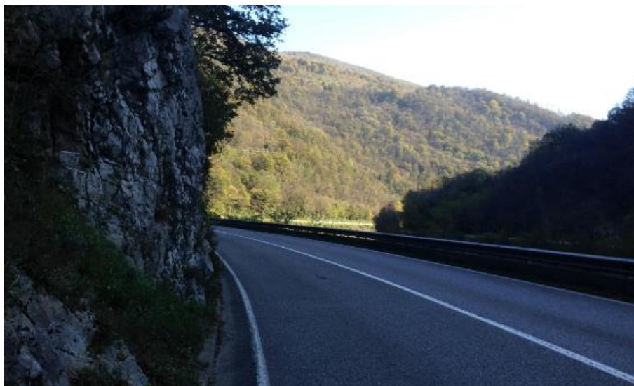
Slika 4.5: Primer grobega skalnatega vseka od km 1,800 do km 2,000, ki sega v prosti profil ceste, pogled v smeri stacionaže
