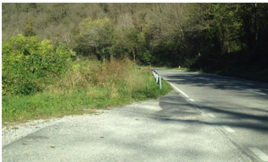
Slika 4.49: Preglednost v levo v območju počivališča od km 2,720 do km 2,750, pogled v nasprotni smeri stacionaže
