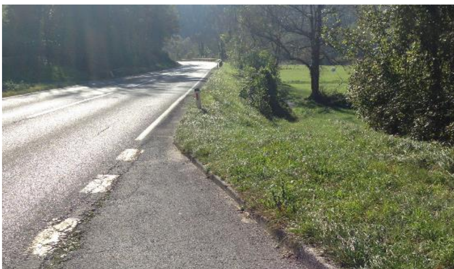
Slika 4.37: Priključek do obdelovalnih površin v km 1,380, pogled v smeri stacionaže
