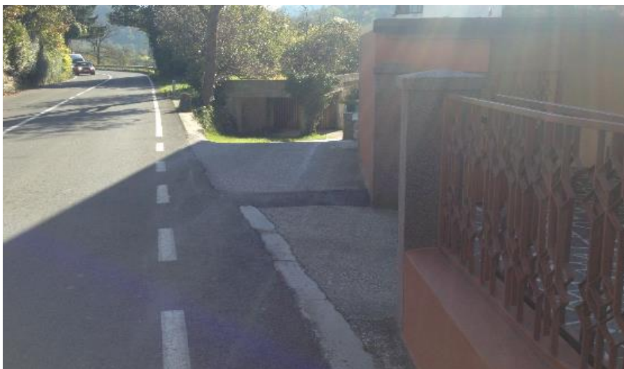
Slika 4.19: Priključek v km 0,060, pogled v smeri stacionaže
