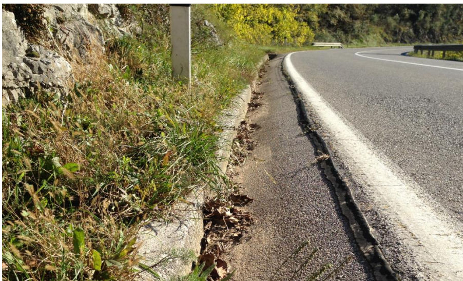
Slika 4.10: Prestrma koritnica od km 0,580 do km 0,750, pogled v smeri stacionaže
