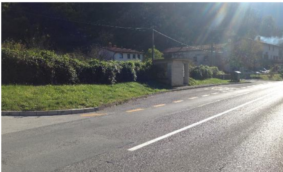
Slika 4.43: Avtobusno postajališče od km 0,310 do km 0,340, pogled v smeri stacionaže
