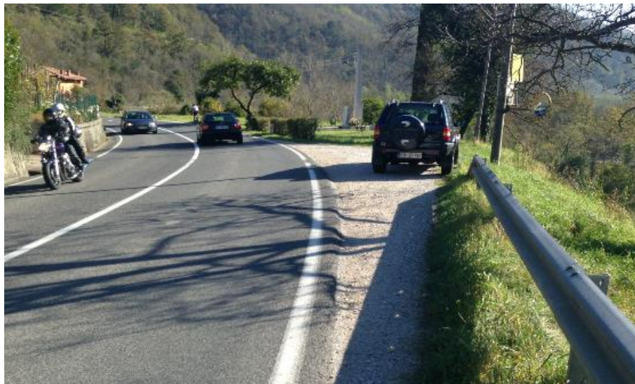
Slika 4.22: Uporaba počivališča od km 0,150 do km 0,170 za priključevanje in izključevanje s priključka v km 0,160, pogled v smeri stacionaže
