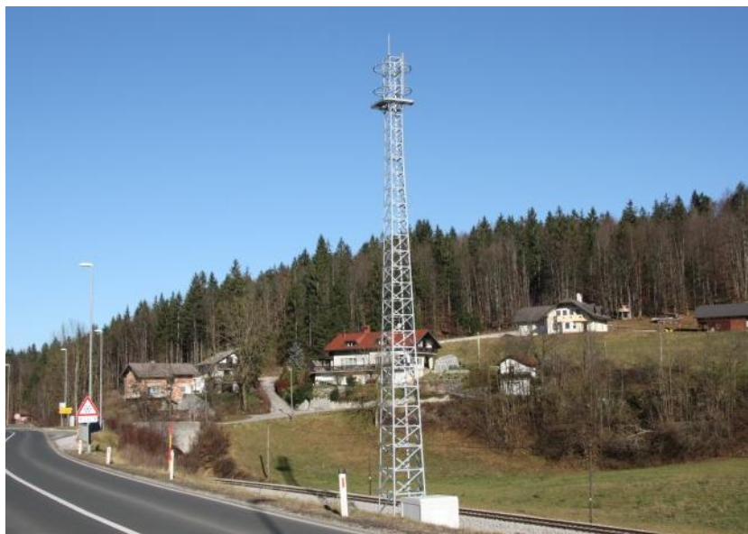
Slika 39: Postavitve antenskih stolpov za vzpostavitev sistema GSM-R (Vlaki.info, 2015d)
