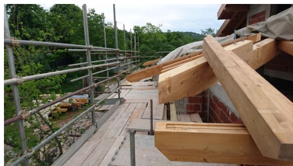
Slika 11: Lesena konstrukcija ostrešja(osebni arhiv)
