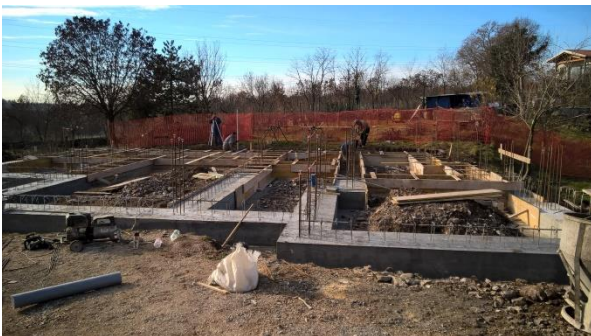
Slika 8: Prva faza temeljev (osebni arhiv)
