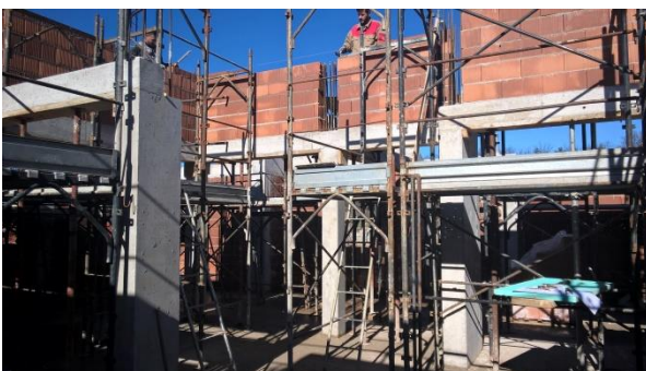
Slika 10: Horizontalne in vertikalne AB vezi (osebni arhiv)
