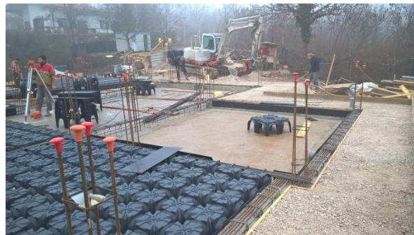
Slika 9: Druga faza temeljev (osebni arhiv)
