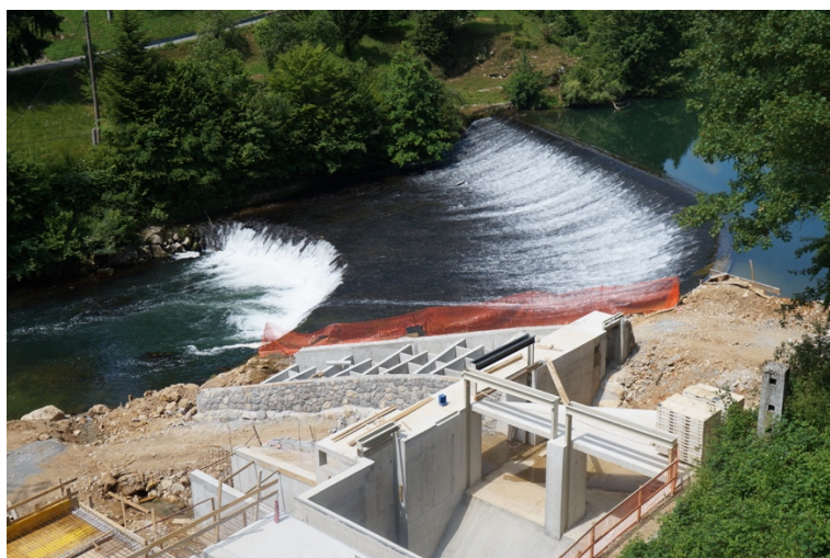
Slika 10: Jez v Fužini – Hidroelektrarna (vir: osebni arhiv, 2016)
