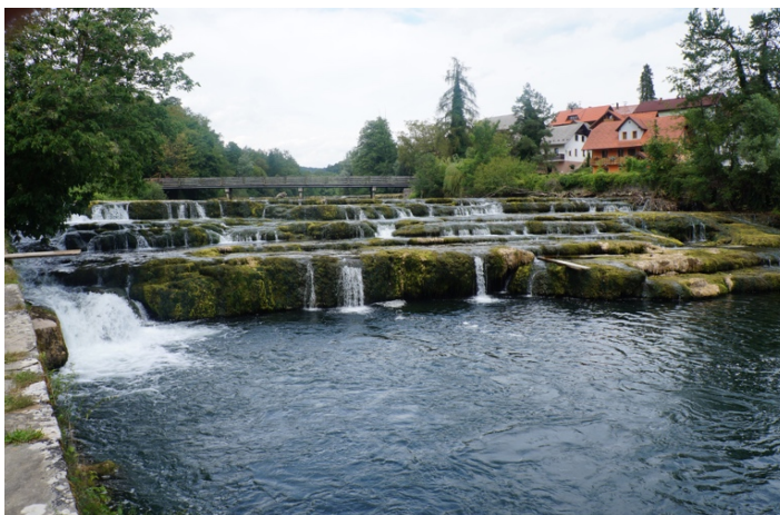
Slika 17: Jez na Dvoru – dolvodno od mostu (vir: osebni arhiv, 2016)
