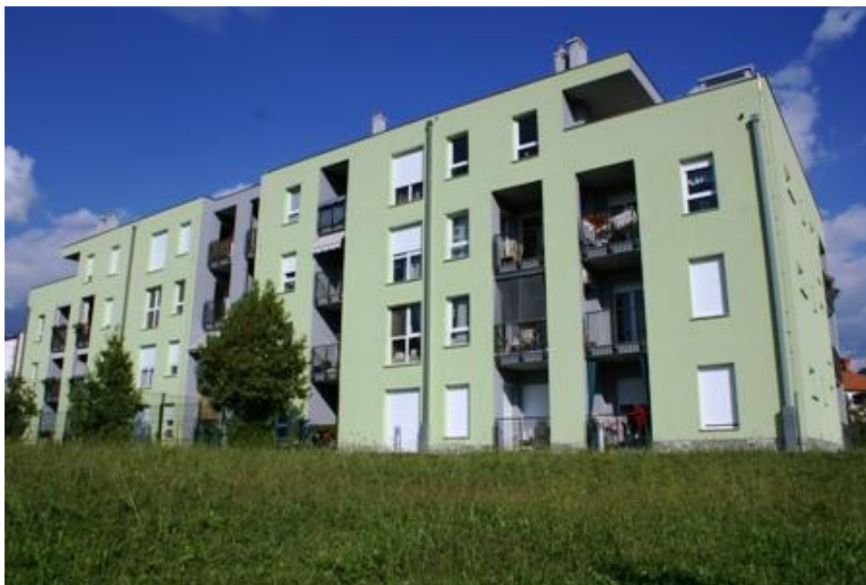
Slika 1: Zidana stavba v Novi Gorici
